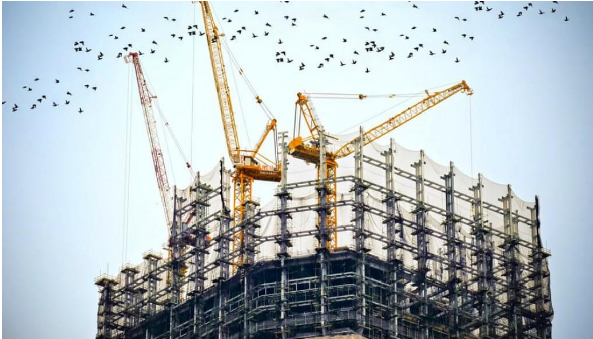
Fig. 2.4 - Foto ripresa dal web
