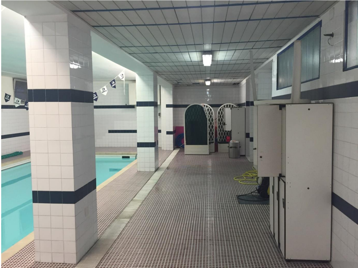
Fig. 3.10 - Corridoio di accesso al piano vasca
