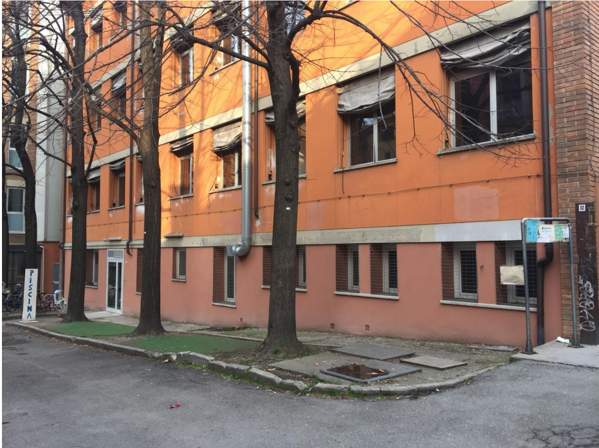
Fig. 3.19 - particolare accesso all'impianto
