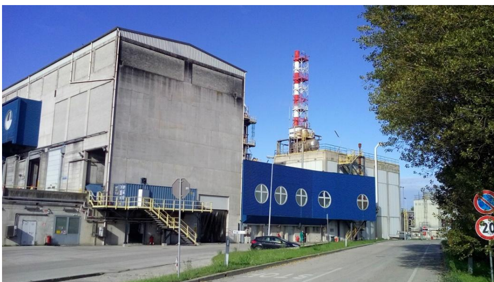
Figura 39: Visione generale dell'impianto adibito a termodistruzione dei rifiuti; (Catterin 2016).
