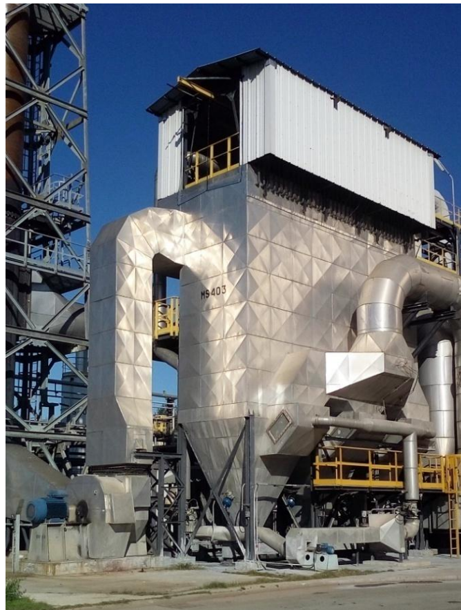
Figura 50: Filtro a maniche presente nel complesso F3; (Catterin 2016).
