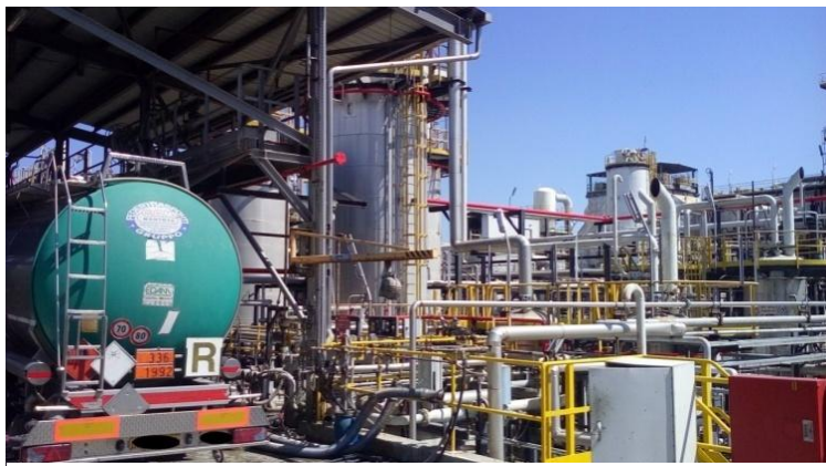
Figura 35: Autobotte in fase di scarico rifiuti liquidi; (Catterin 2016).
