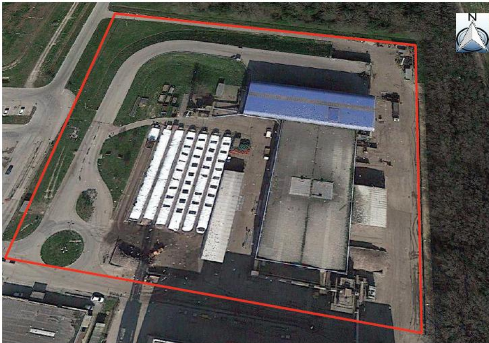
Figura 8.8. Impianto di produzione CSS e Biotunnel
