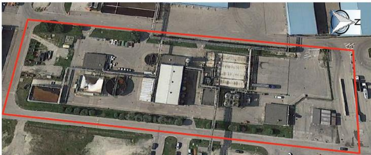
Figura 8.12. Impianto di trattamento chimico-fisico (TCF)
