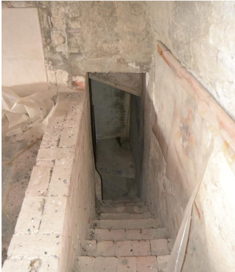
Scala di accesso alle coperture del blocco ovest
