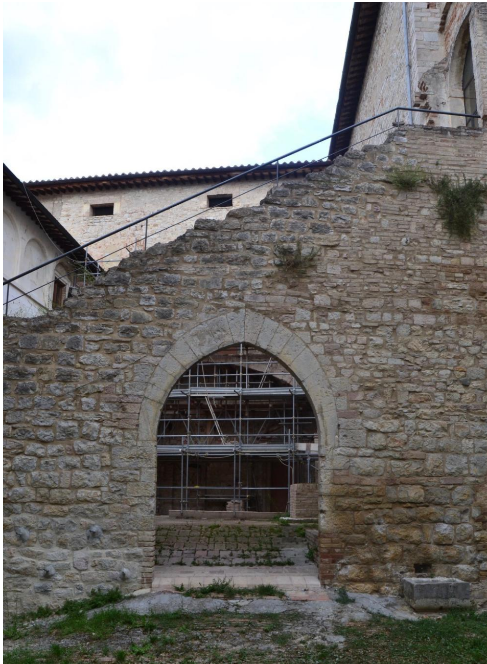
Cortile delle botteghe, scala esterna che conduce al Salone d'onore. Oltre l'arco è visibile il ponteggio utilizzato per i lavori di restauro delle decorazioni pittoriche e intonaci della loggia del cortile d'onore (2003), attualmente funge da supporto per le esercitazioni dei corsi della Scuola Edile
