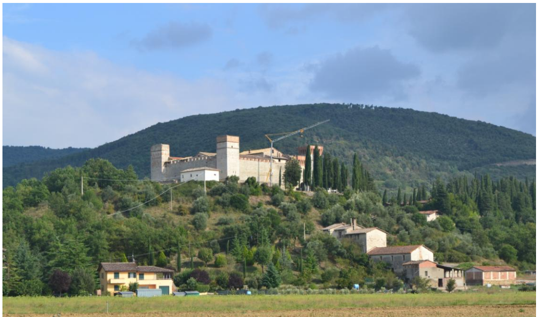
Vista dei lati nord e ovest del castello di Pieve del Vescovo, adiacente alla torre di nord-ovest è visibile il blocco esterno al complesso chiamato “casa del pellegrino”
