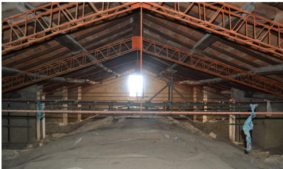
Estradosso volta e struttura della copertura del salone d'onore
