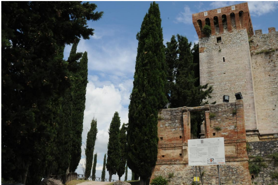
Torre sud-ovest e strada di accesso al castello, visibile il cartello di cantiere della Scuola Edile per i lavori di restauro
