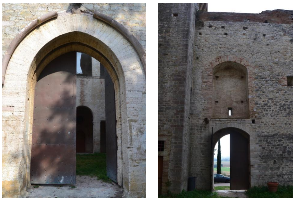
Veduta da fuori e dentro le mura della porta d'ingresso originaria del castello, nella foto a destra è visibile il vano di alloggiamento per lo scorrimento dal basso verso l'alto
