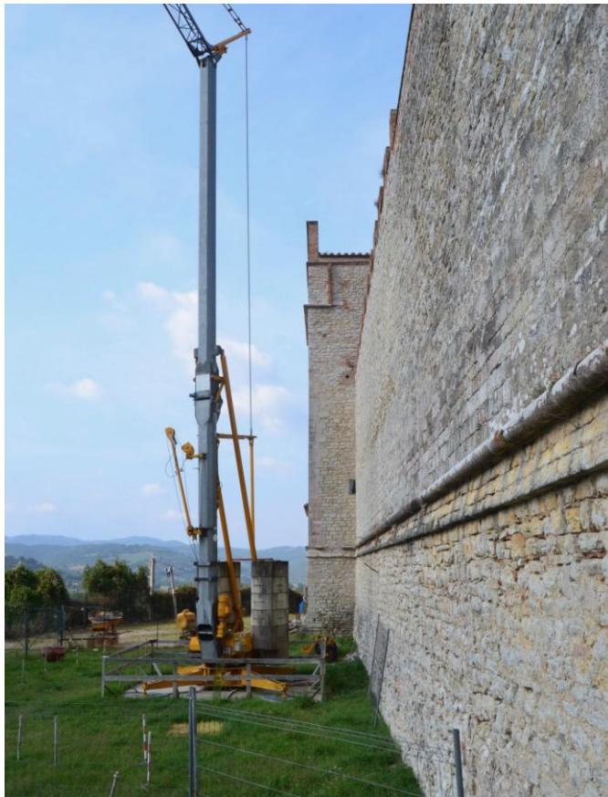
Allestimento di gru e altre attrezzature da cantiere nel lato ovest del complesso, utilizzate come esercitazioni nei corsi della Scuola Edile
