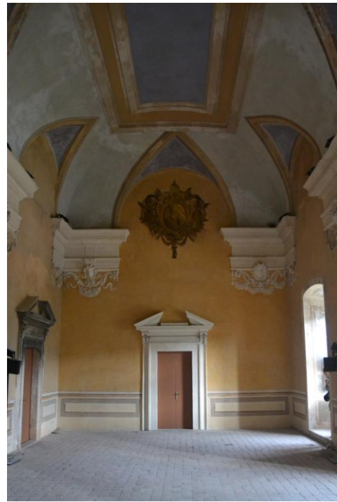
A sinistra, la volta della Chiesa di San Giovanni che necessita un consolidamento, a destra, il Salone d'onore, che presenta un notevole avvallamento nella pavimentazione a causa del cedimento della volta sottostante
