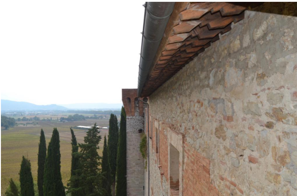
Vista dalla torre sud-ovest della muratura esterna in prossimità della copertura, ben visibile la diversa natura dei mattoni, conseguenza delle ristrutturazione subite nel corso degli anni
