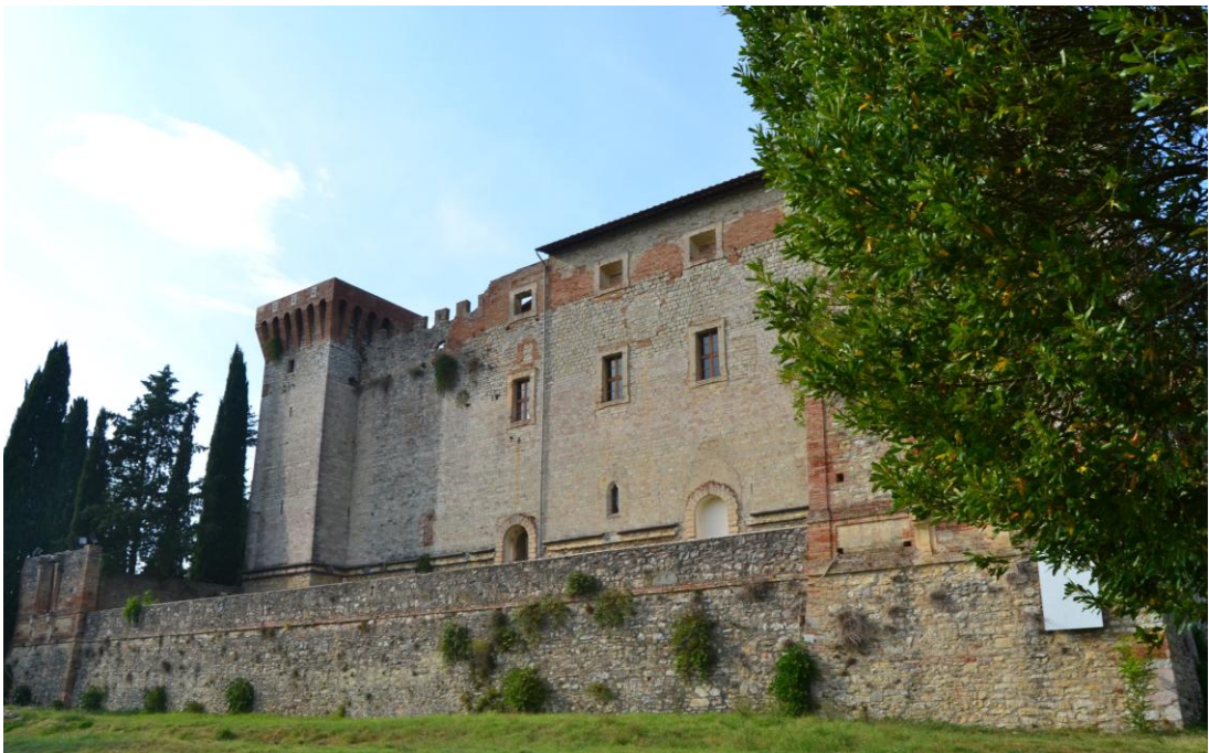
Vista della facciata sud del Castello di Pieve del Vescovo
