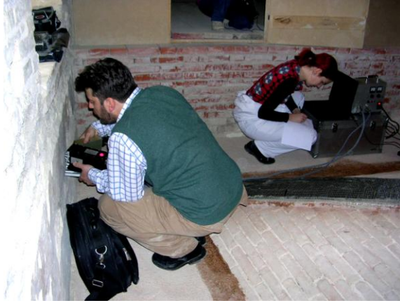
Sondaggi sulla muratura eseguiti in occasione del consolidamento della volta della sala del Pergolato dagli studenti della Scuola Edile (17)
