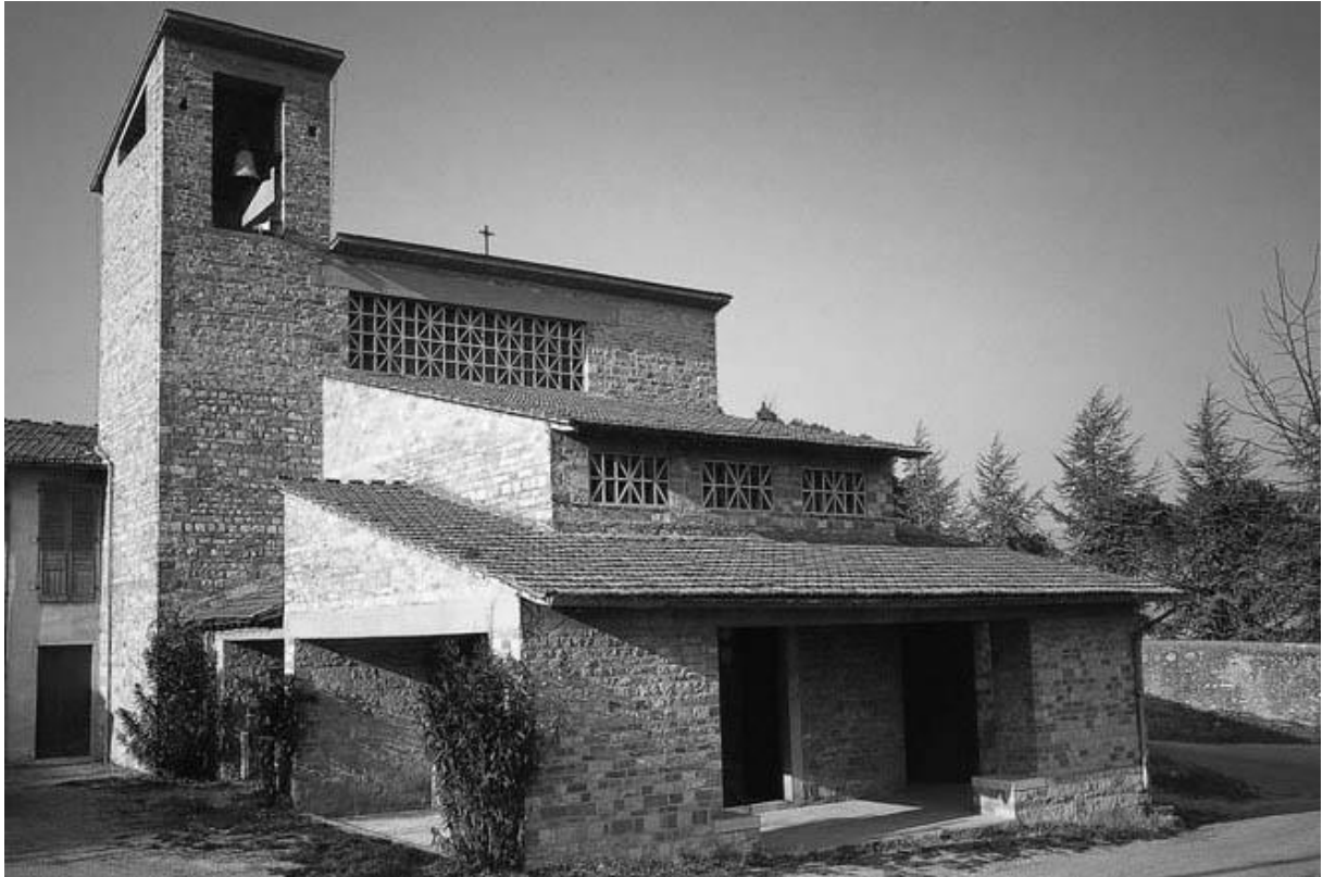
Figura 35. Chiesa dei Santi Pietro e Girolamo, Collina di Pontelungo (Pistoia) di G. Michelucci. Vista dall'esterno.
