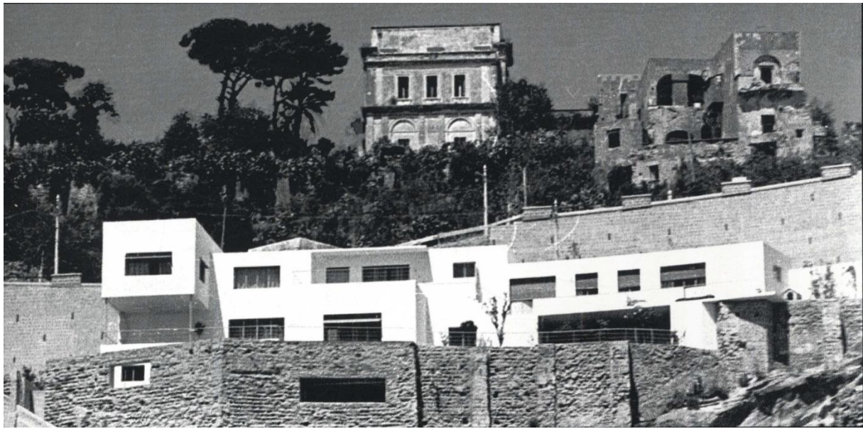
Figura 21. Villa Oro, Napoli. Fronte sul lato mare di L. Cosenza.
