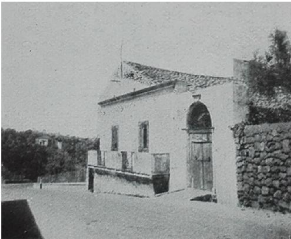
Figura 74. Tipico balcone della Sicilia Orientale costituito da un avancorpo a sostegno di questo. Dall'alto: casa presso Fiumefreddo; casa presso Giarre.
