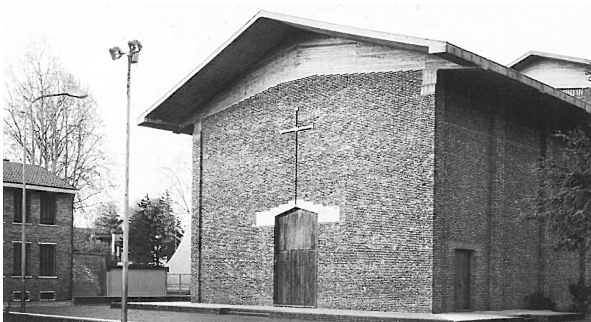
Figura 26. Chiesa di S. Francesco D'Assisi, quartiere Ina- Casa di Cesate, Milano di I. Gardella. Vista esterna.
