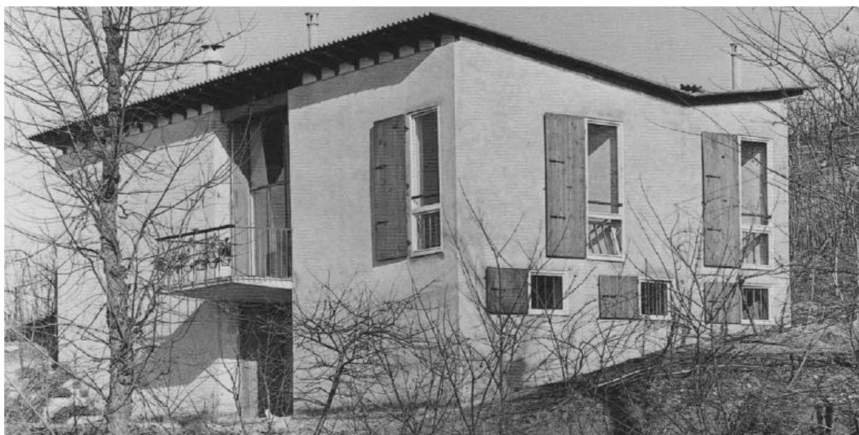
Figura 24. Casa Barbieri, Castana (Pavia) di I. Gardella. Vista dell'esterno.
