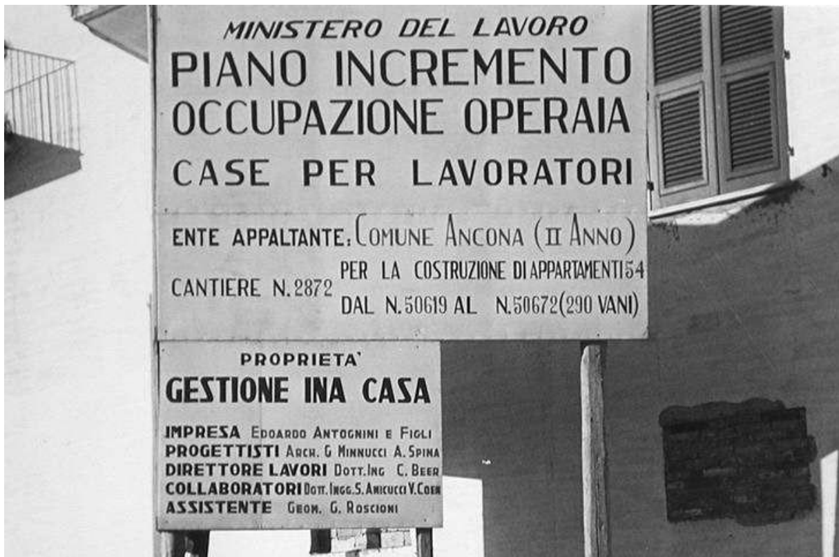
Figura 13. Cantiere di un quartiere Ina-casa.
