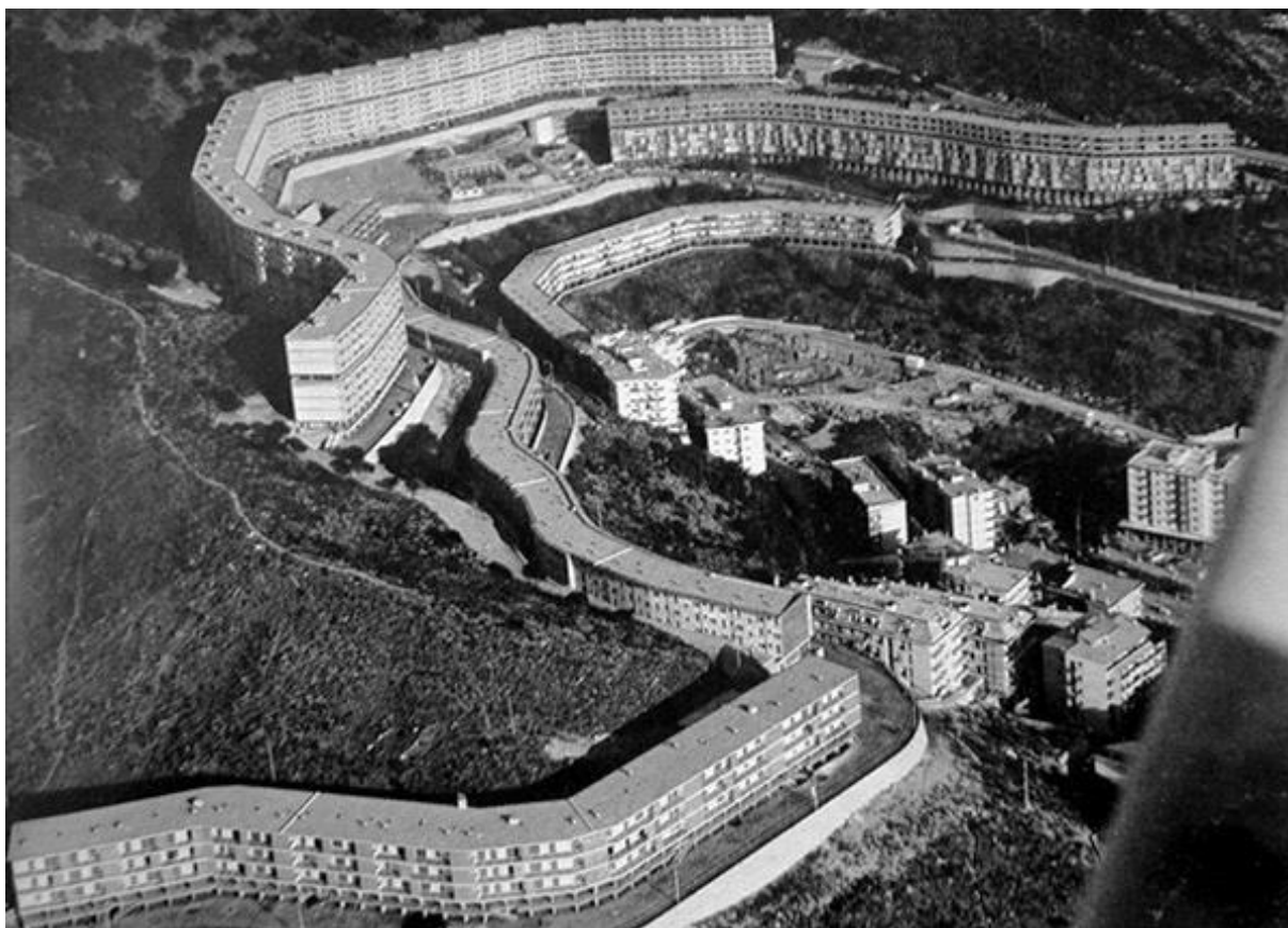
Figura 15. Quartiere Ina-casa a Forte Quezzi (Genova), 1956-68, L.C. Daneri.
