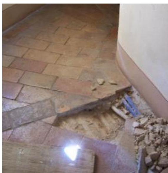
Volta sopra pianerottolo della scala principale
