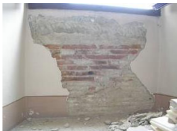
Particolare muratura portante mista pietra-laterizi
