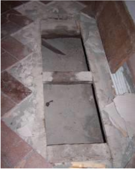
Particolare solaio in legno al secondo
