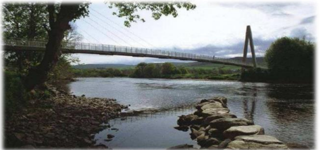
Panoramica del ponte pedonale di Aberfeldy - "Aberfeldy Golf Club", Scozia
