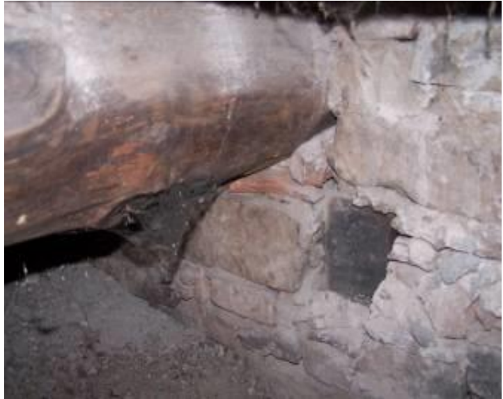
Particolare innesto trave principale del solaio al piano primo
