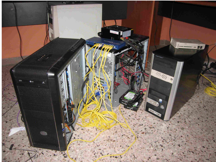
Figura 4.2: Foto della realizzazione dell'architettura
