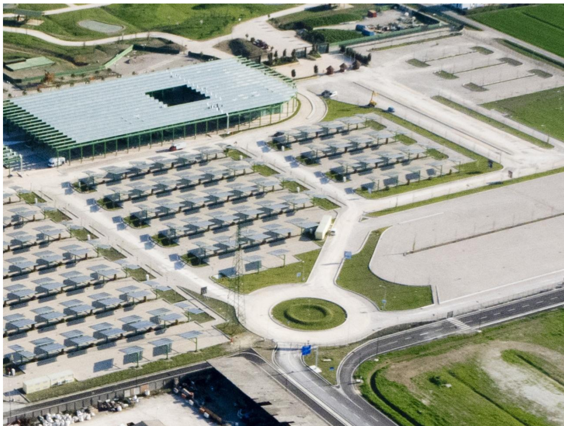
Figura 73: esempio di parcheggio con copertura fotovoltaica
