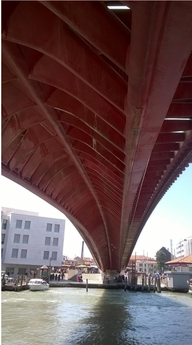
Figura 23, Visione dal basso dei cinque archi portanti che costituiscono l'ossatura del ponte della Costituzione.
