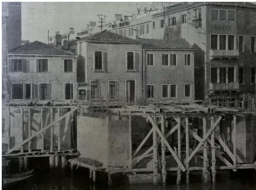
Figura 19, I cassoni della Spalla Nord prima dell'affondamento, (Miozzi, 1935).
