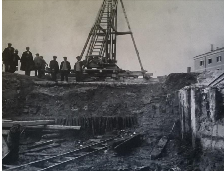
Figura 3, Paletti di vecchie fondazioni rinvenute nello scavo del Rio Novo, (Miozzi, 1934)
