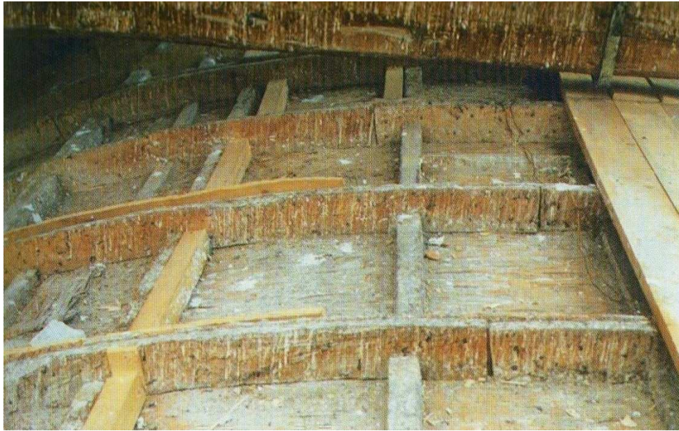
Fig. 4: Consolidamento centine con nuove tavole e nuovi tambocchi
