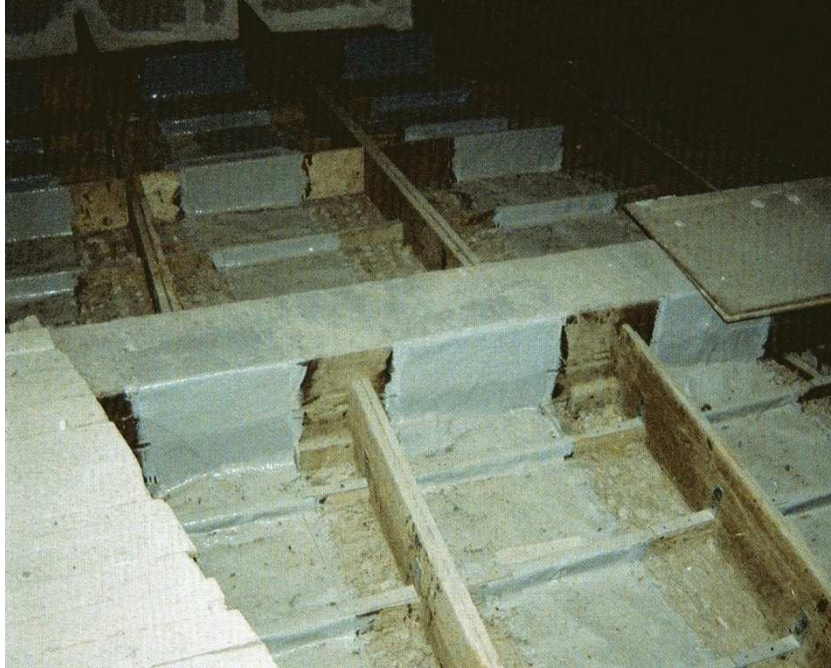
Fig. 7: Consolidamento a fasce mediante FRP
