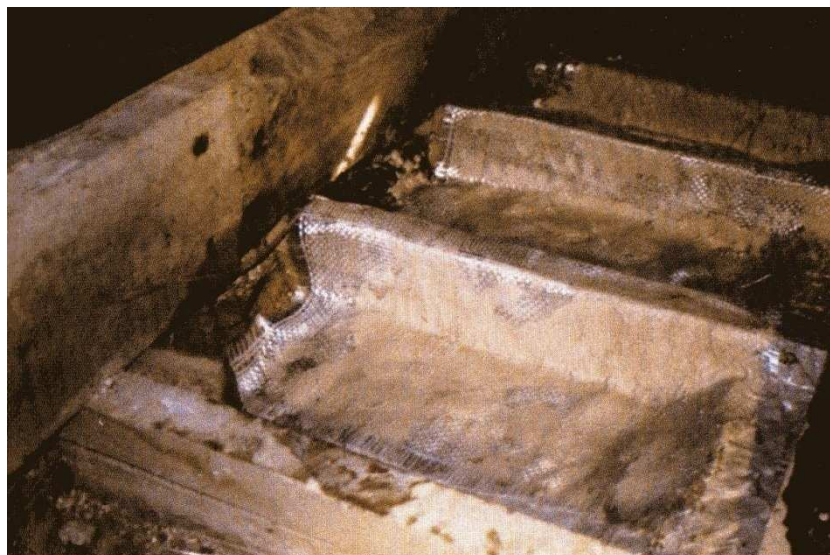
Fig. 6: Stesura del primo strato di materiale composito FRP
