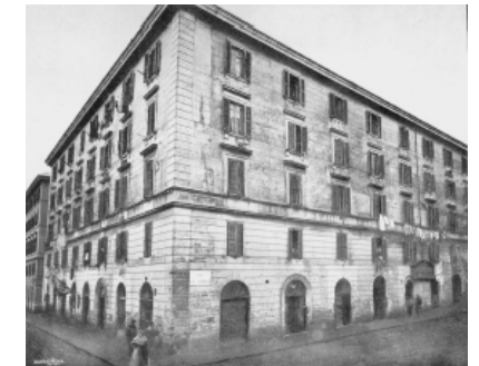
L'edificio storico in cui fu realizzata la Casa Montessori dei bambini a Roma nel quartiere San Lorenzo
