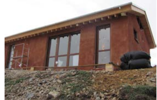
Fig. 2.18. Foto di cantiere del progetto E.V.A. a Pescomaggiore (AQ).
