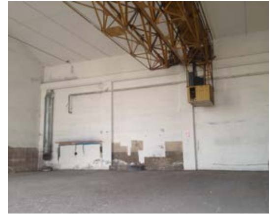
Fig. 5.2. Esempio di cantiere con misure di sicurezza insufficienti
