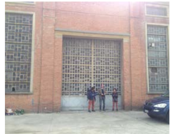
Fig. 5.3. Esempio di cantiere con misure di sicurezza insufficienti
