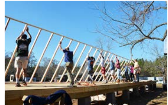
Fig. 2.11. I Rural Studio in uno dei loro cantieri.
