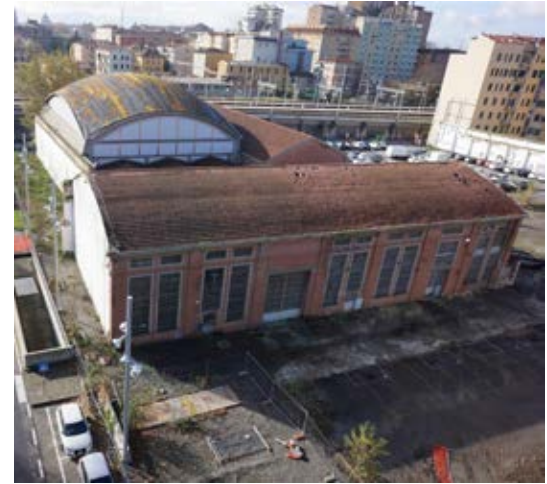
Fig. 2.24. Esterno dell'Ex fabbrica Manzini dove verrà preassemblato il Modulo Eco.
