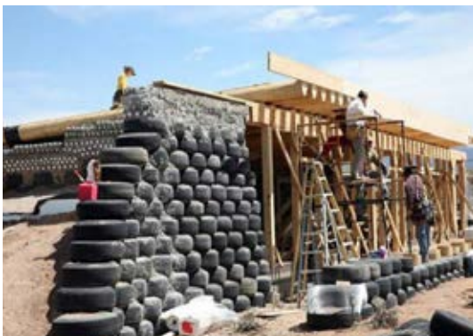
Fig. 2.7. Fase di cantiere di un'Earthship.
