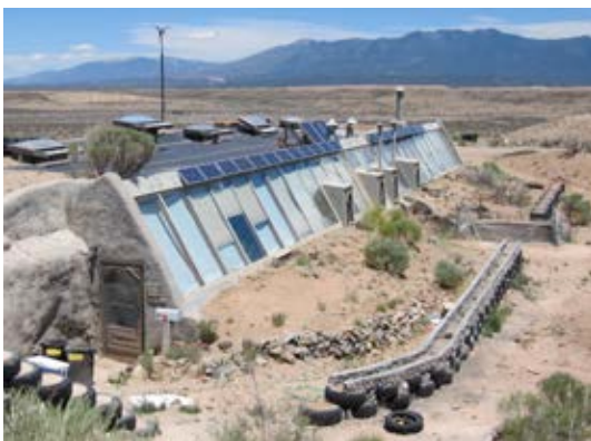
Fig. 2.6. Esempio di Earthship presso Taos, New Mexico.
