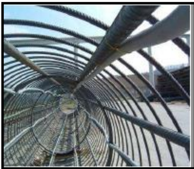
Figura 15. Particolare del posizionamento dei tubi all'interno dell'armatura.
