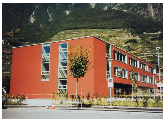
Figura 7. Visuale dell'edificio scolastico di Fully nel Vallese costruita secondo lo standard Minergie.
