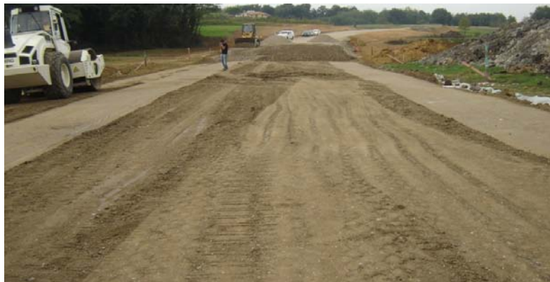
Fig.4.11 Compattazione delle fasce esterne del sito sperimentale
