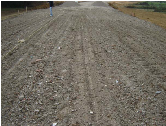
Fig.4.19 Particolare campo pre-compattazione
