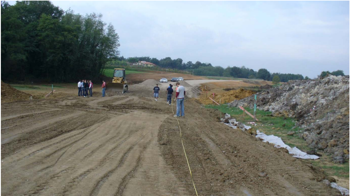
Fig.4.3 Rilevato sperimentale ad Altopascio prima della compattazione
