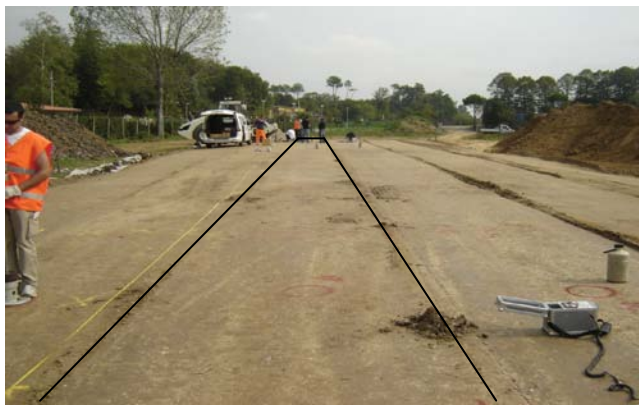
Fig. 4.16 Rilievo fascia a 4 passaggi
