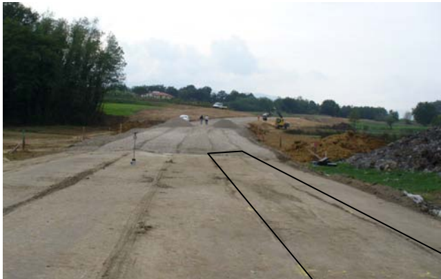
Fig. 4.14 Rilievo fascia a 2 passaggi
