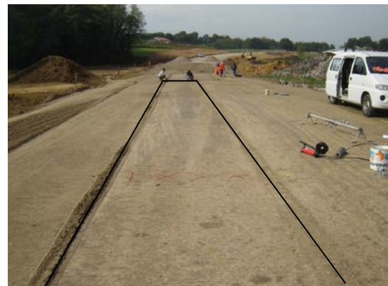
Fig. 4.17 Rilievo fascia a 8 passaggi
