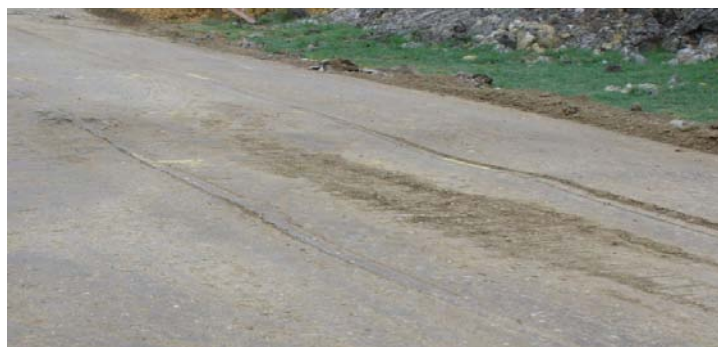
Fig.4.13 Zone umide, avvallamenti e geotessile presente nel campo A2-5
