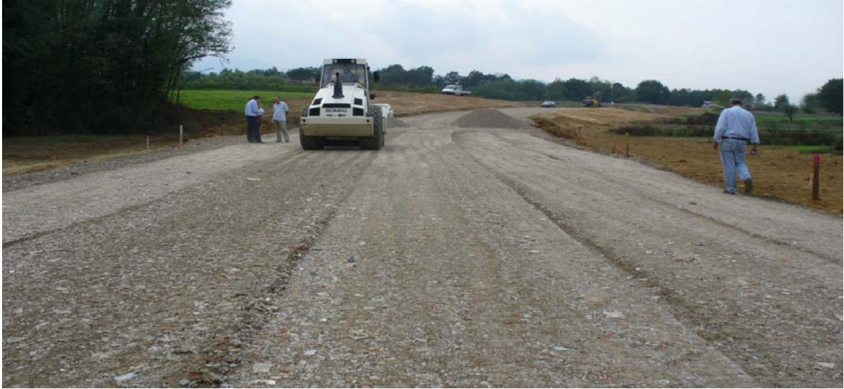
Fig.4.10 Campo in materiale C&D dopo la compattazione
