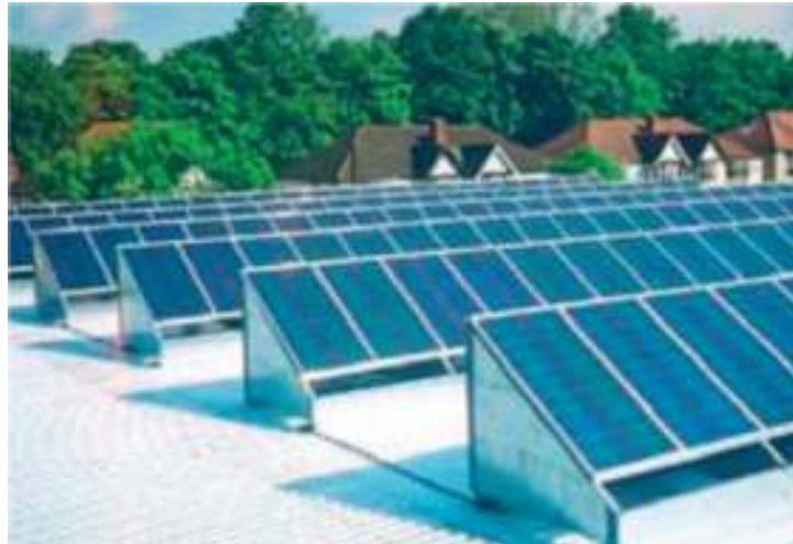
Fig. 1.6 – Impianto Solare Fotovoltaico [29]
