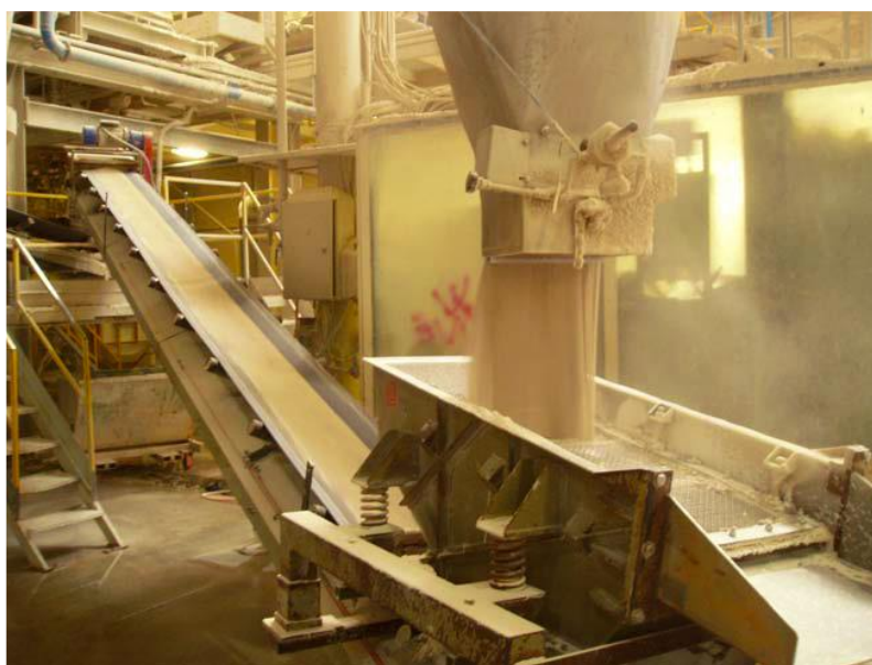
Fig1.3 – Uscita atomizzatore e nastro trasportatore (Fonte: Saccani C., Environmental impact reduction in the ceramics industry: conveying parameters control for atomized slip pneumatic transport).
