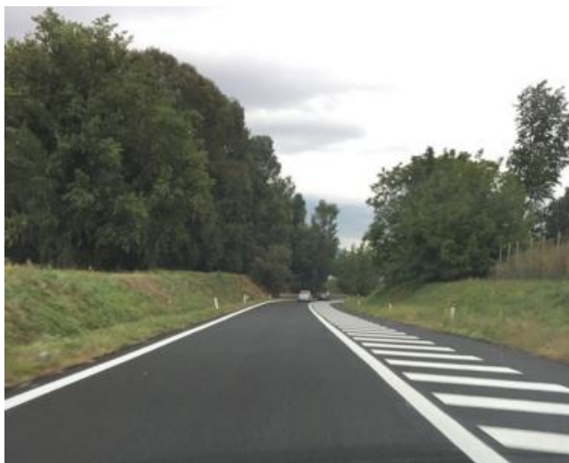
Figura 2-2 Uso del tratteggio nella zona interna di una curva, l'effetto è quello di restringimento della carreggiata
