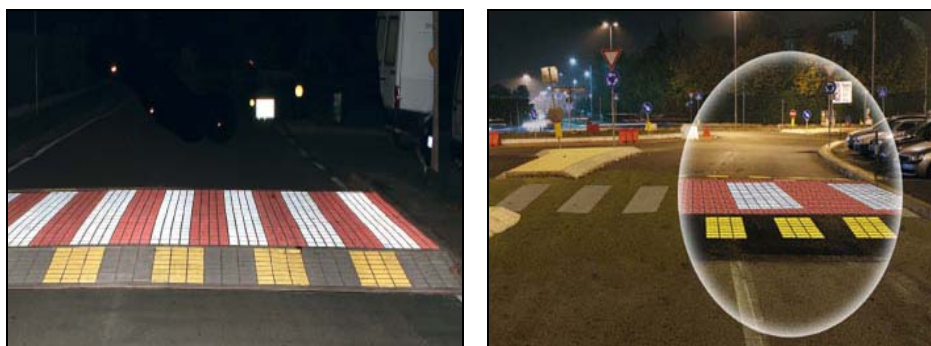
Foto 134: esempio di attraversamento pedonale rialzato ed evidenziato
