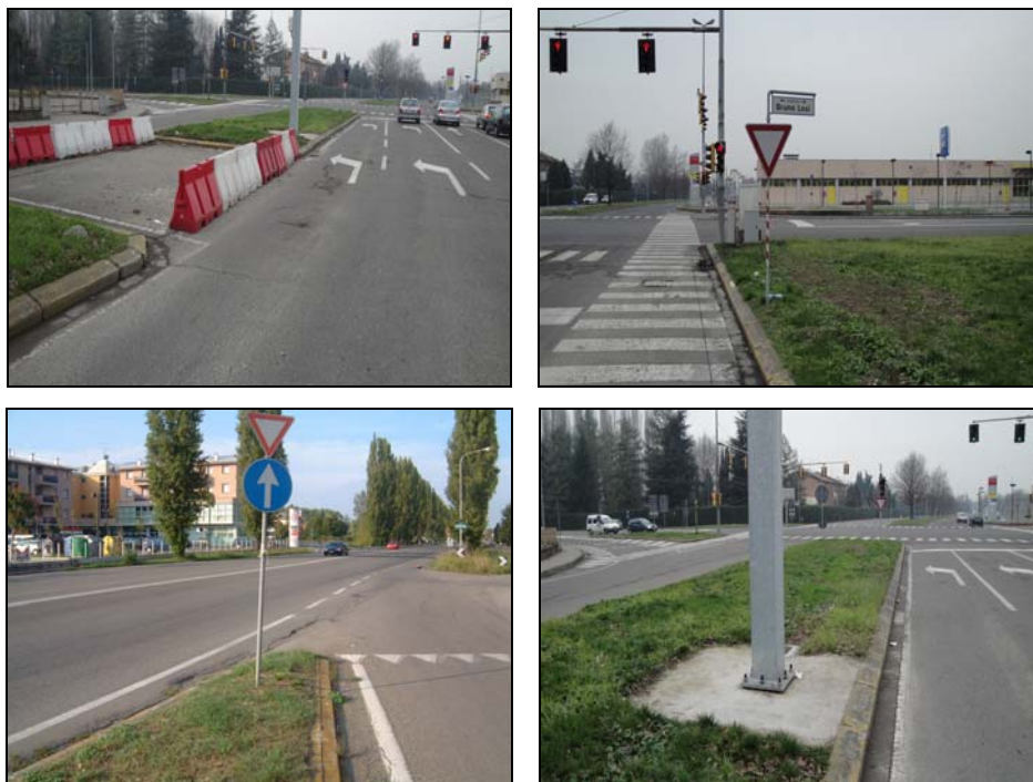
Foto 166: esempio di segnaletica verticale pericolosa
