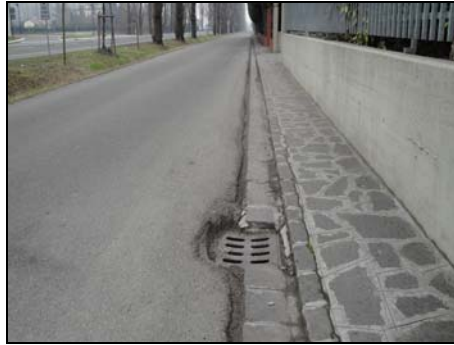
Foto 175: immagine del marciapiede
