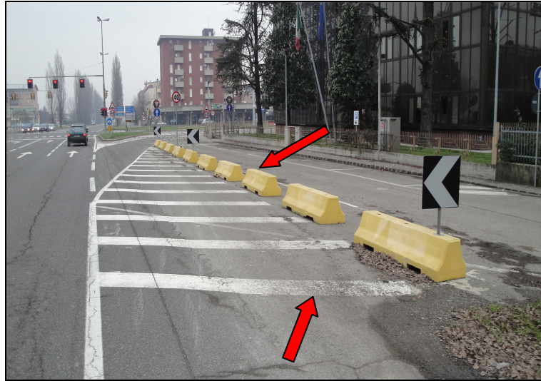
Foto 40: foto di elementi a margine pericolosi e segnaletica degradata
