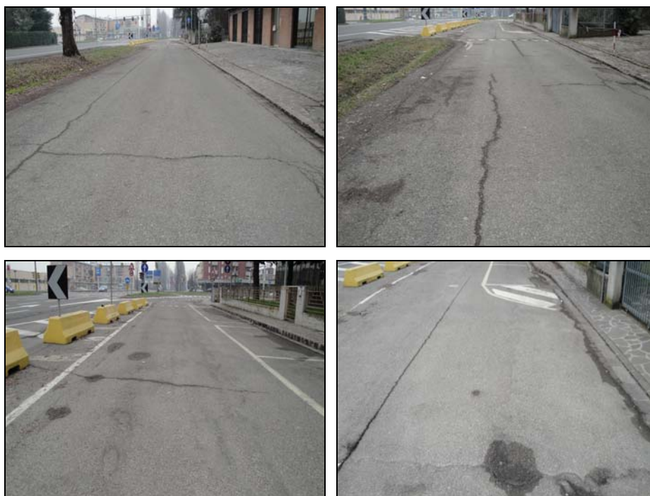
Foto 135: immagini di pavimentazione esistente
