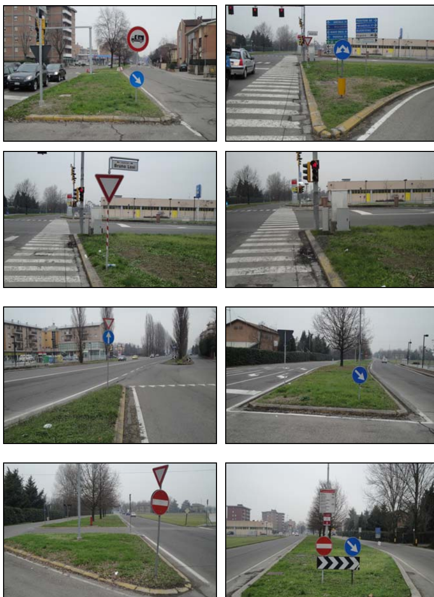
Foto 183: esempi di elementi pericolosi
