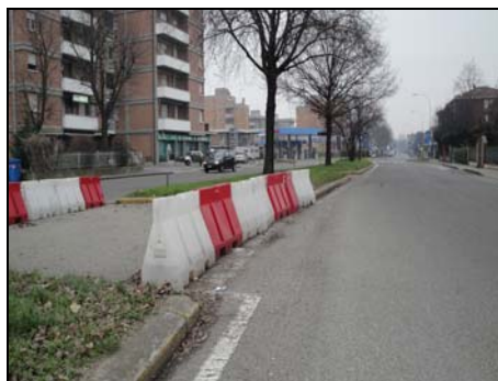
Foto 158: esempio barriera spartitraffico pericolosa
