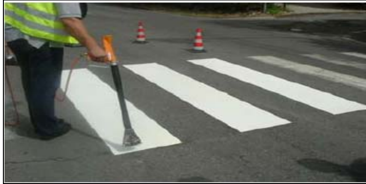
Foto 113: esempio di pannello preformato termoplastico posizionato con bruciatore a propano
