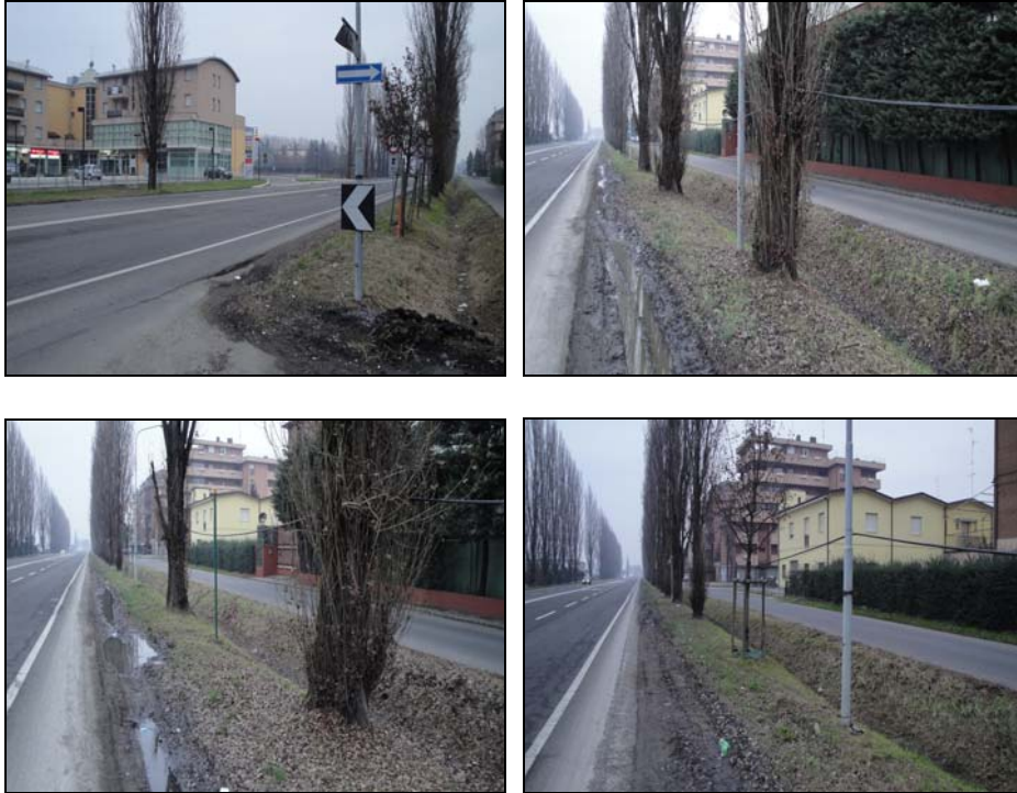
Foto 91: immagini di elementi a bordo strada non protetti e pericolosi
