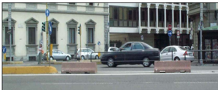
Foto 71: barriere miste acciaio-calcestruzzo utilizzate come spartitraffico in un'intersezione
