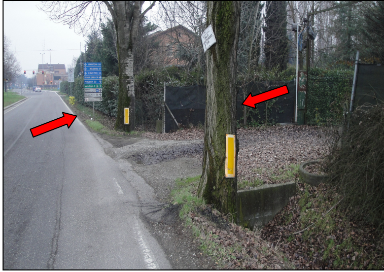
Foto 41: foto di elementi a margine pericolosi
