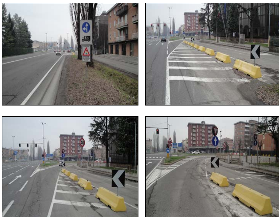
Foto 128: immagini di segnaletica verticale pericolosa
