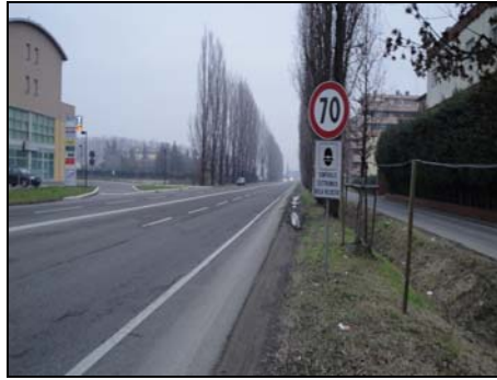
Foto 93: immagine di segnaletica verticale pericolosa
