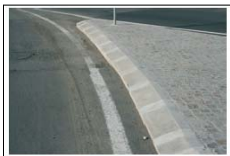
Foto 181 : esempio di cordoli in gomma
