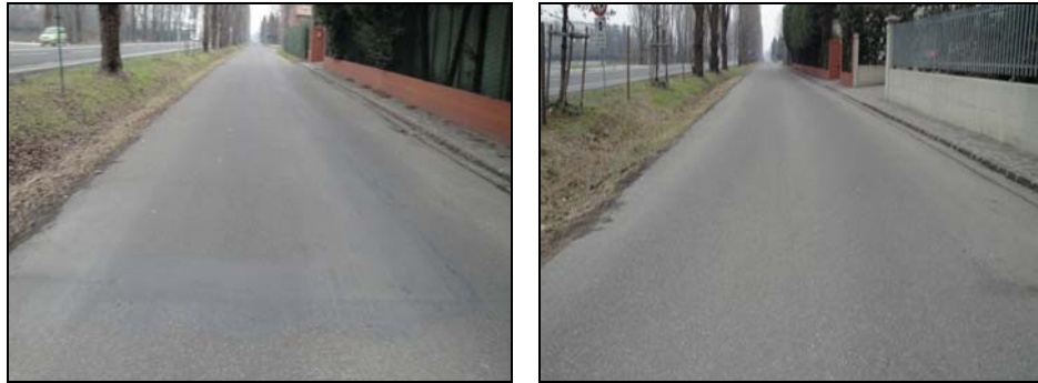
Foto 169: condizioni della pavimentazione
