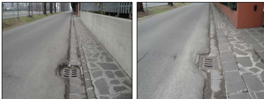
Foto 170: condizioni della pavimentazione
