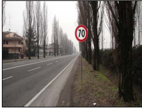
Foto 118: immagini di segnaletica verticale pericolosa
