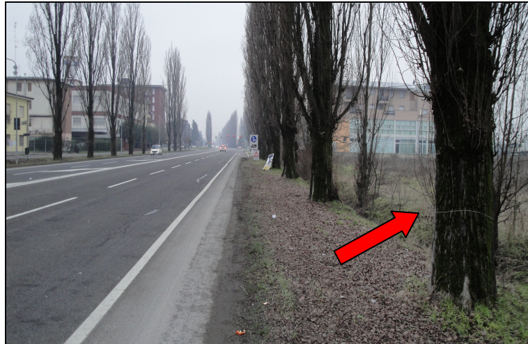
Foto 38: foto di vegetazione pericolosa
