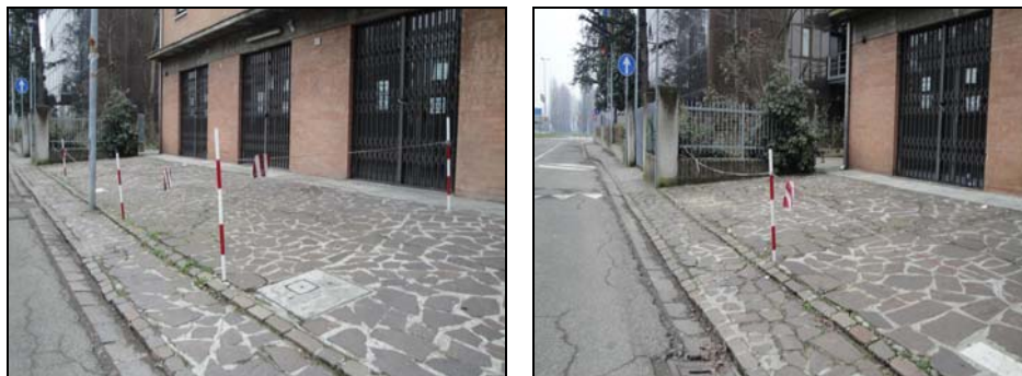
Foto 142: esempio di arredo urbano pericoloso
