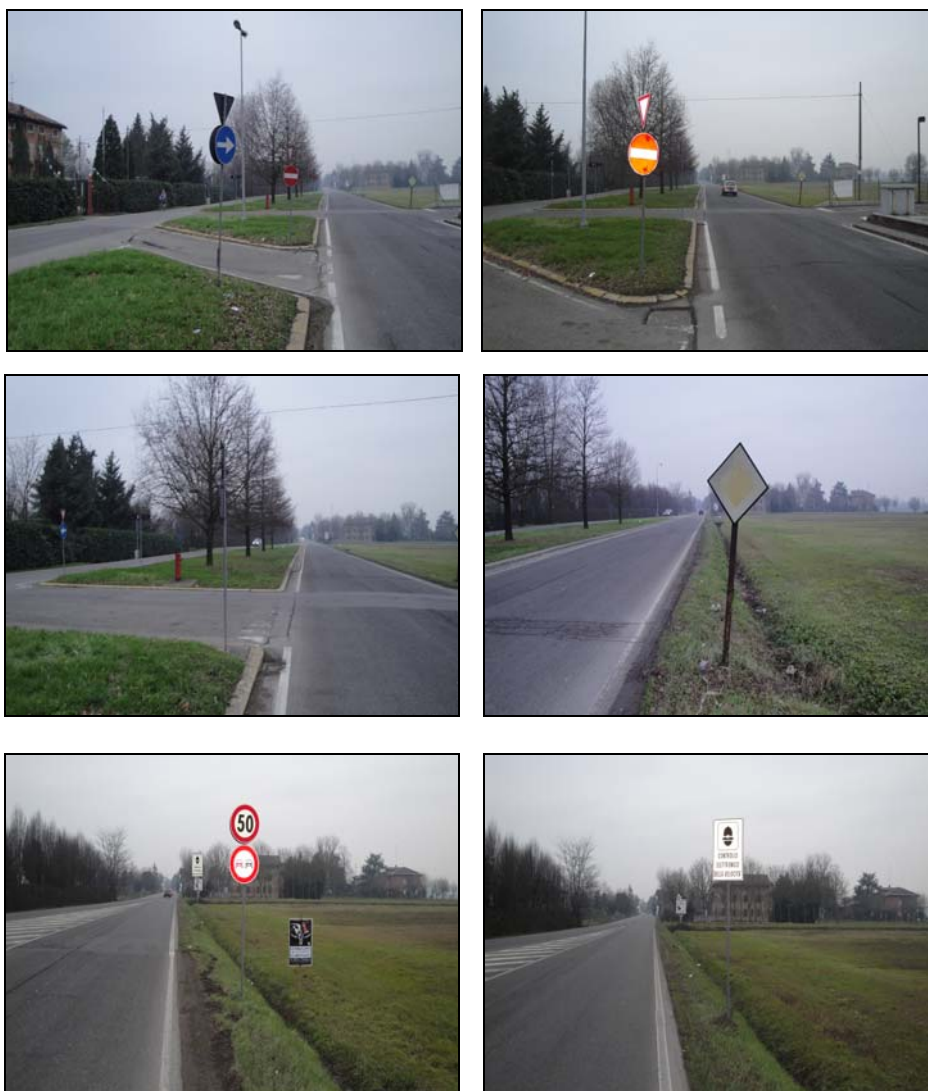
Foto 102: immagini di segnaletica verticale pericolosa
