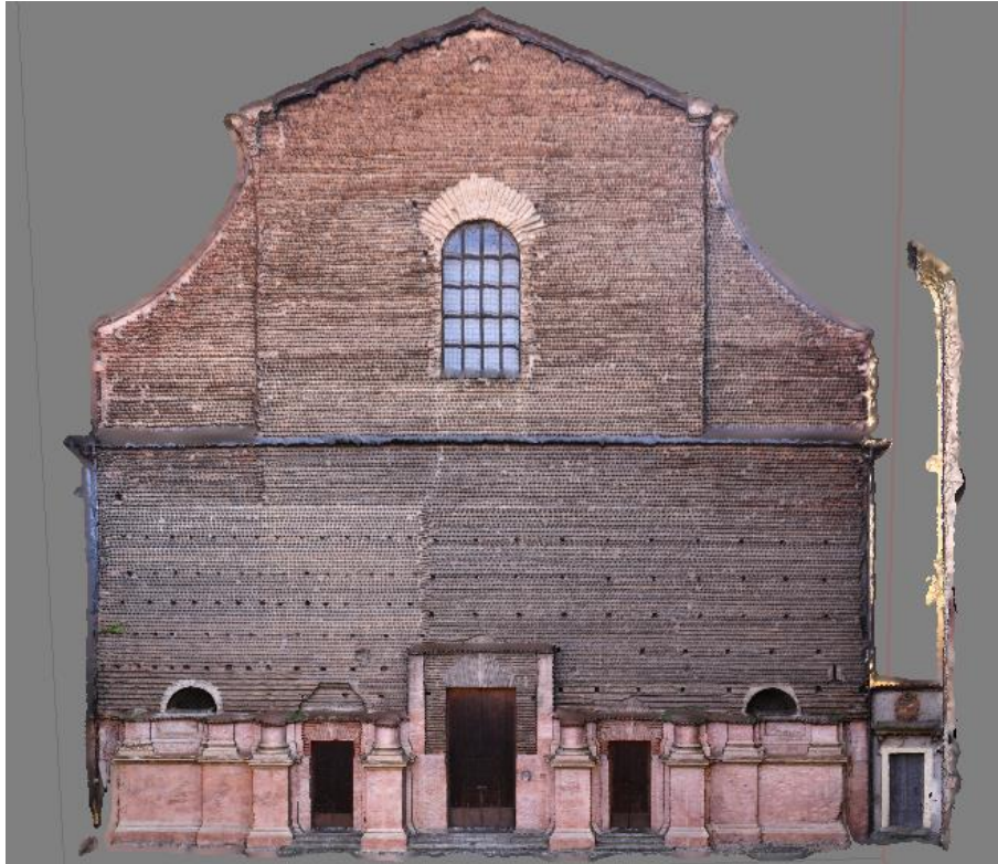
Figura 126: Vista centrale della facciata
