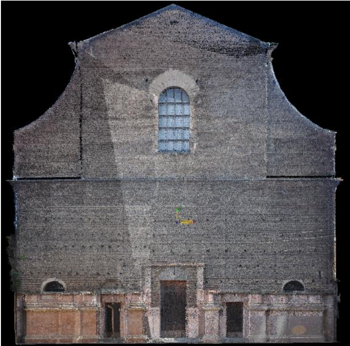
Figura 105: Nuvola densa di punti ottenuta dal rilievo TLS. Ogni punto restituito è corredato da un valore radiometrico ricavato dalle immagini sincrone acquisite dalla camera digitale montata sopra il Laser. I punti sono definiti in un sistema di coordinate cartesiano ortogonale locale orientato lungo la verticale.
