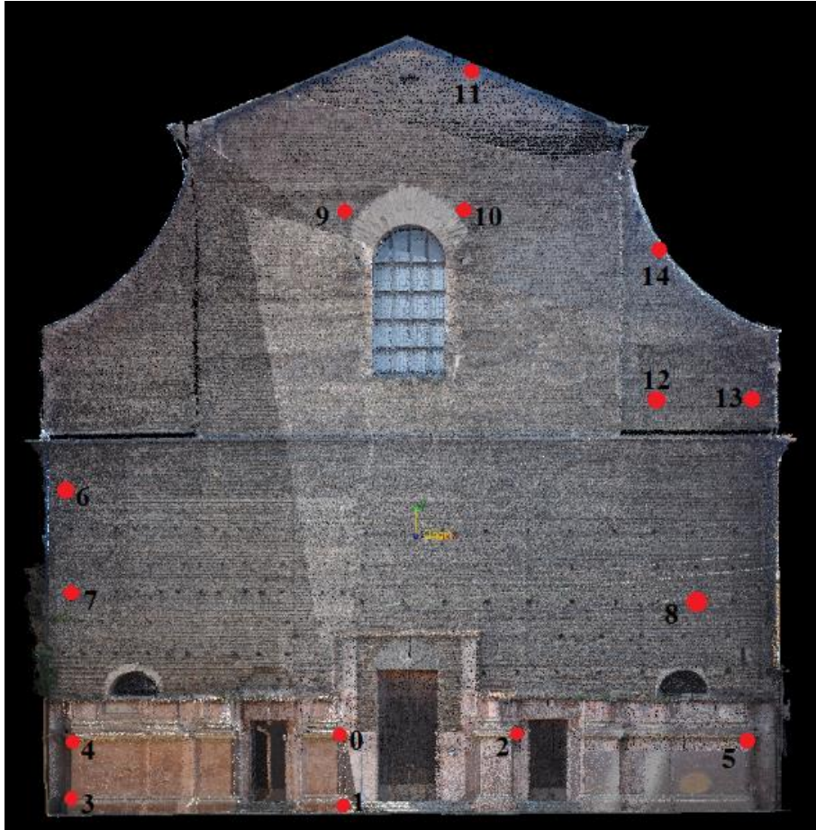
Figura 203: Distribuzione dei punti su cinque livelli differenti della facciata.
