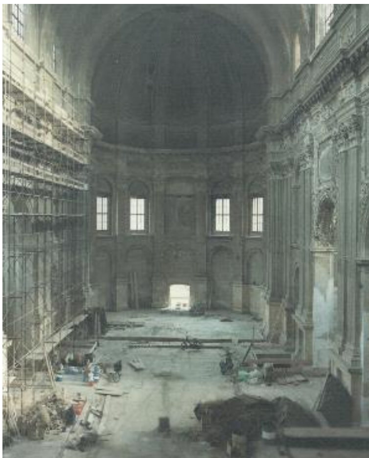
Figura 87: Cantiere per il restauro della navata principale (Archivio storico website).
