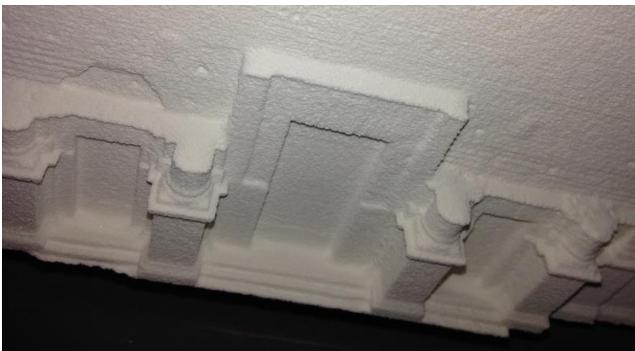
Figura 214: Particolare del portone principale alla base della facciata.
