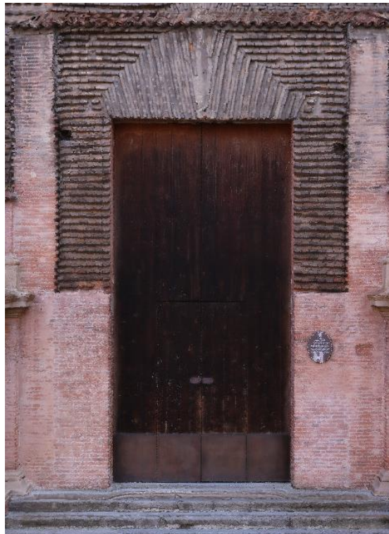
Figura 132: Dettaglio del portone principale texturizzato.
