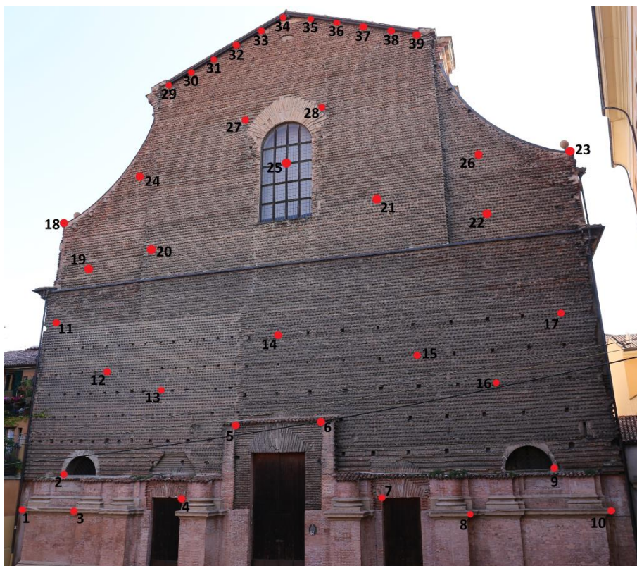
Figura 107: Posizione approssimata dei punti fotogrammetrici di appoggio.
