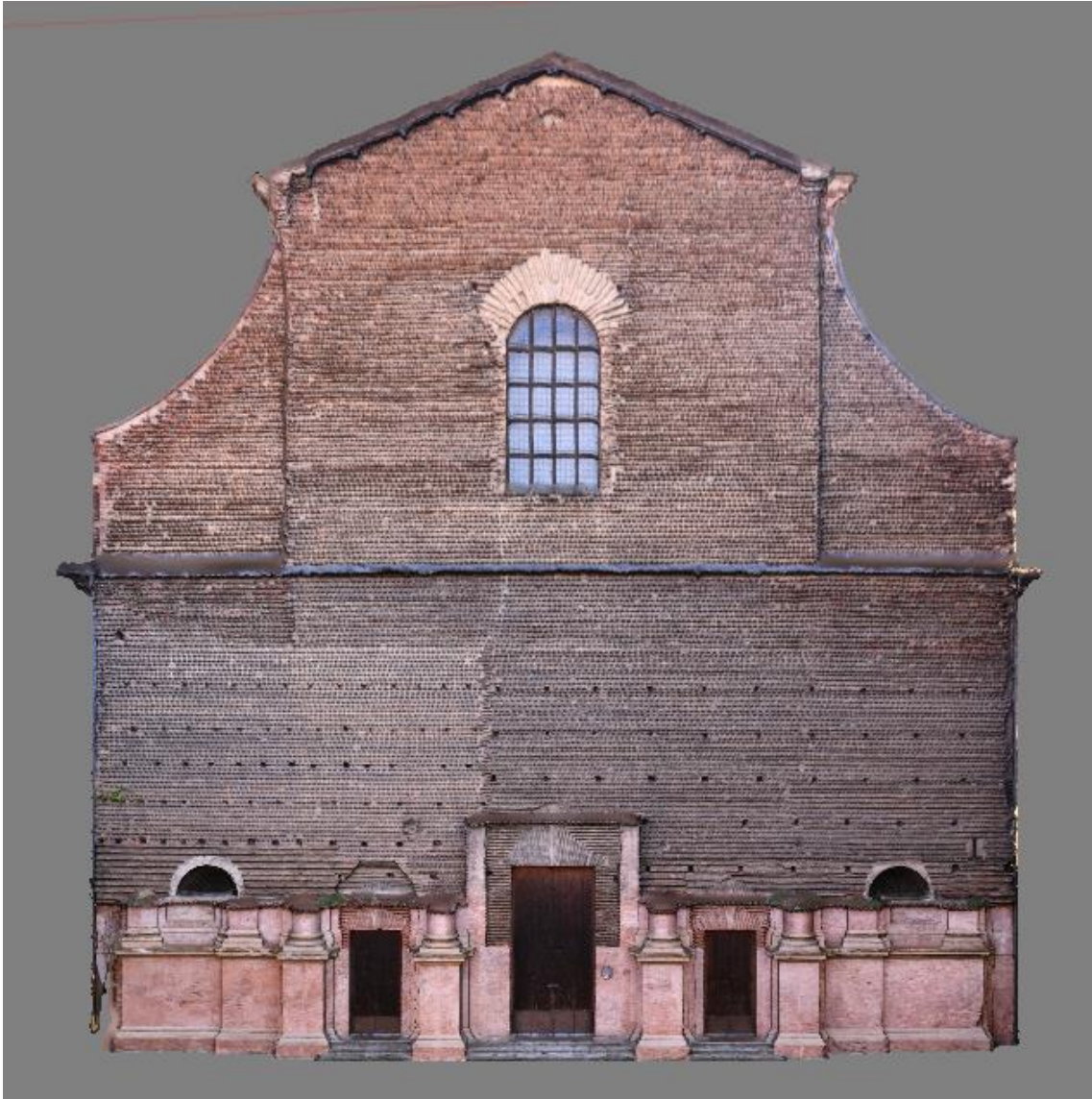
Figura 128: Nuvola densa del prospetto frontale della facciata.
