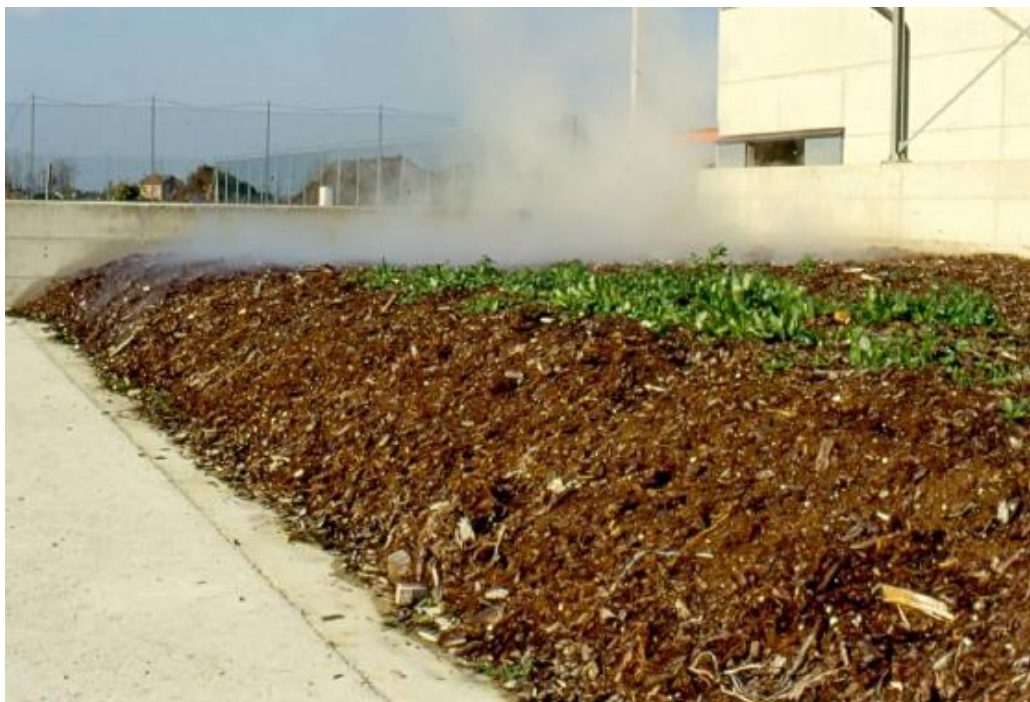
Figura 3.23: Esempio di biofiltro per il trattamento delle emissioni odorigene
