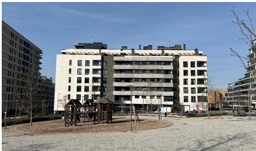
Vista del parco, posto sul lato ovest, rispetto al lotto di intervento (Fonte: autori)
