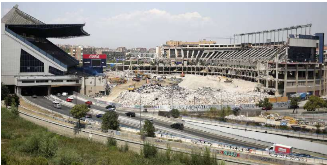
Fasi di demolizione del vecchio stadio (Fonte: EL PAÍS, 2019)
