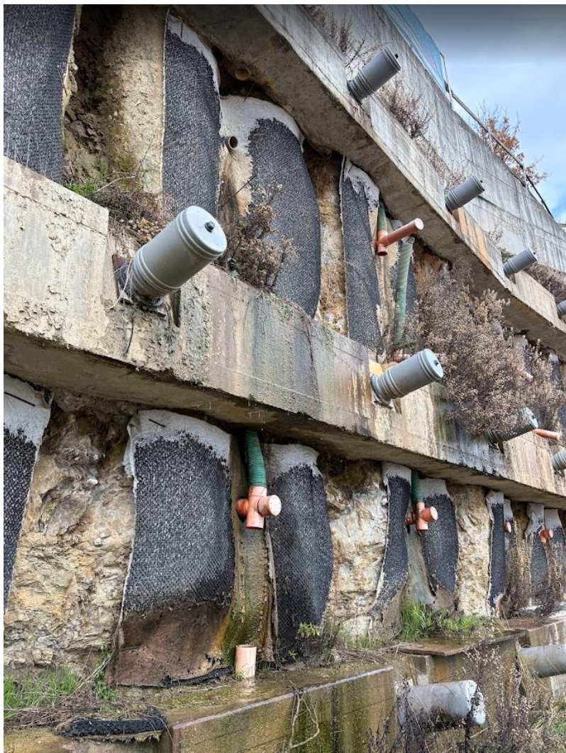
Figura 2.3 Dettaglio berlinese dreni e tiranti
