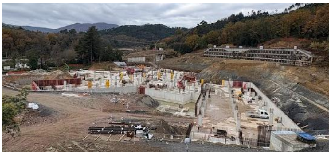
Figura 2.5 Area cantiere nuovo ospedale sopralluogo 09/12/25
