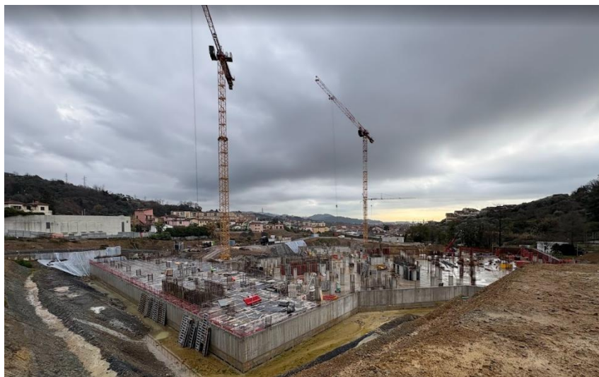
Figura 2.6 Area cantiere nuovo ospedale sopralluogo 15/01/26
