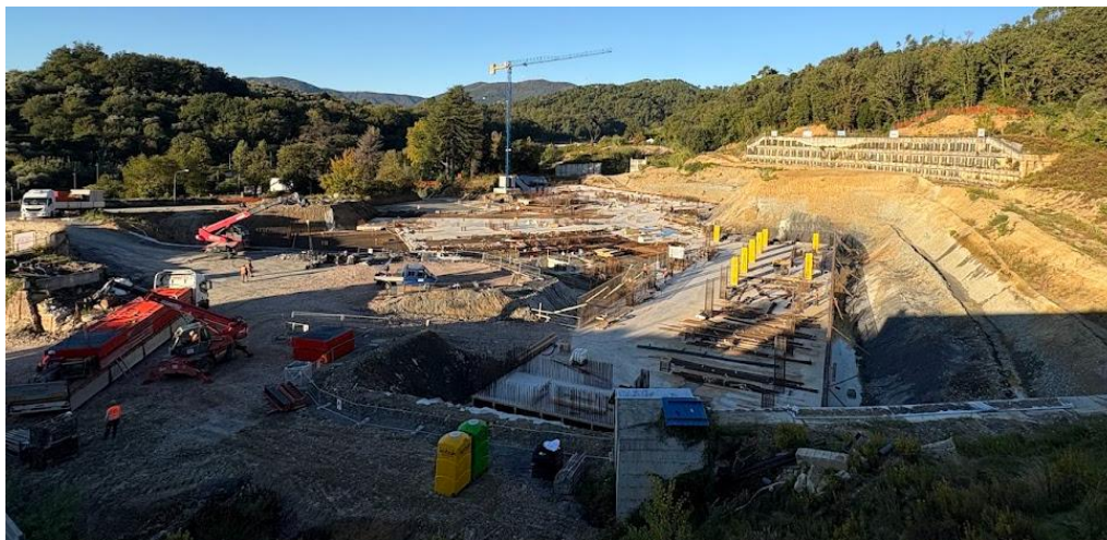
Figura 2.4 Area cantiere nuovo ospedale sopralluogo 16/10/25
