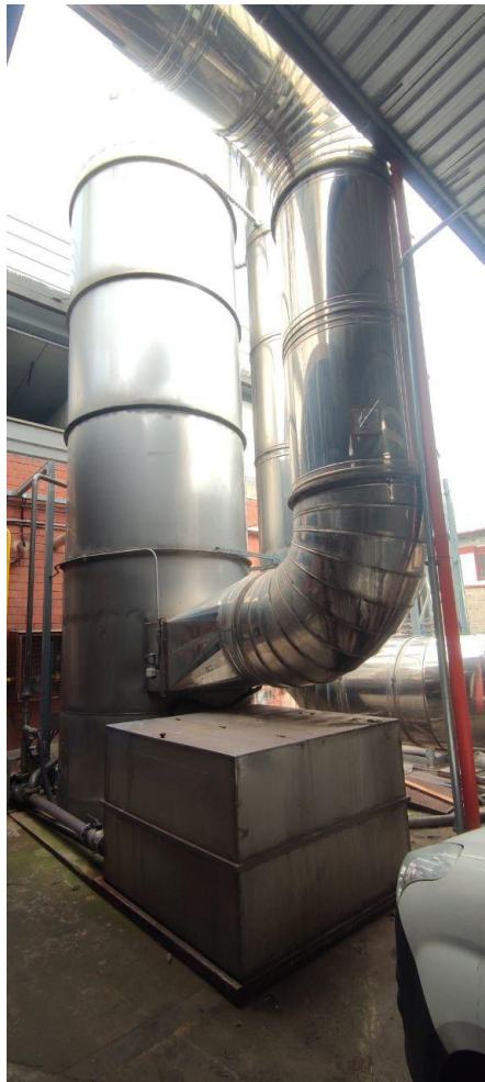
Figura 13a Impianto scrubber dell’azienda Tessiltoschi
