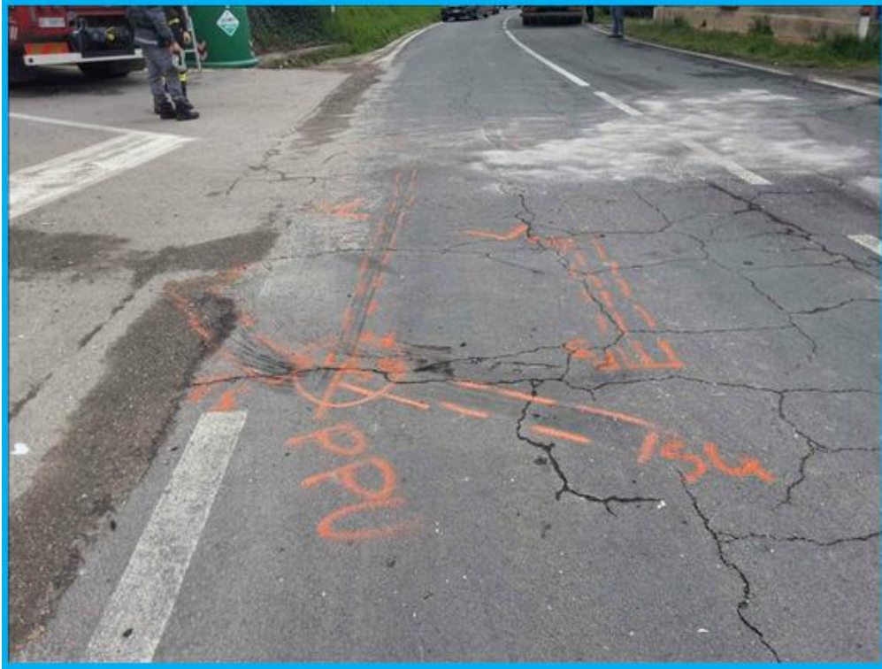
Figura 7: dettaglio del presunto punto d'urto e delle tracce gommose di scarrocciamento e frenata prodotte dalla Fiat 500, giusto la direzione di marcia della Toyota RAV4.
