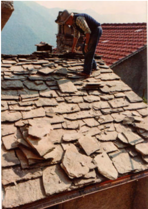
Figura 1.10 "manto di copertura "a piagne"
