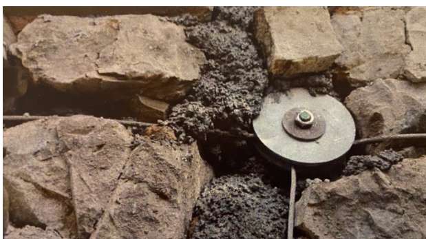
Figura 5.3: Dettaglio della rondella con trefolo metallico sottofuga
