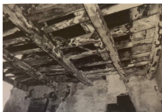
Figura 1.11: Chiusure orizzontali intermedie piane con solaio ligneo riscontrati nel comune di Camugnano
