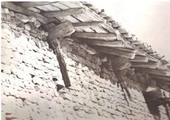
Il legno nelle costruzioni appenniniche era impiegato per i solai che vedevano una struttura principale, orientata parallelamente alla dimensione minore del vano, costituita da travi squadrate di 20x30 cm circa, disposte ad intervalli variabili ed innestate nella muratura per circa metà del suo spessore.
