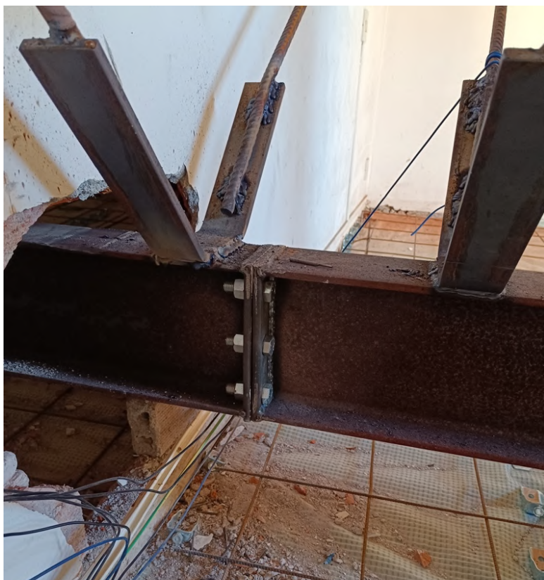
Fig. 42_ Immagine delle selle in acciaio del sistema di tiranti per sostenere la trave per la sospensione del solaio a metà campata. (Scatto in cantiere)
