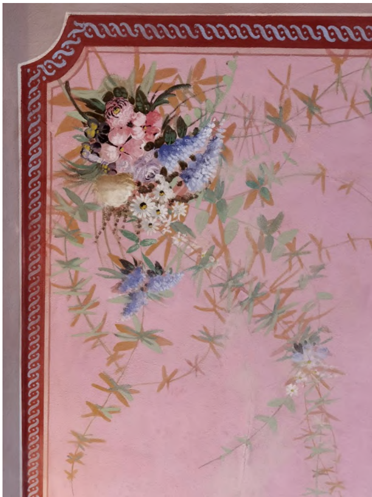
Fig. 45_ Particolare di decorazione a soffitto dopo il restauro. (Scatto in cantiere)
