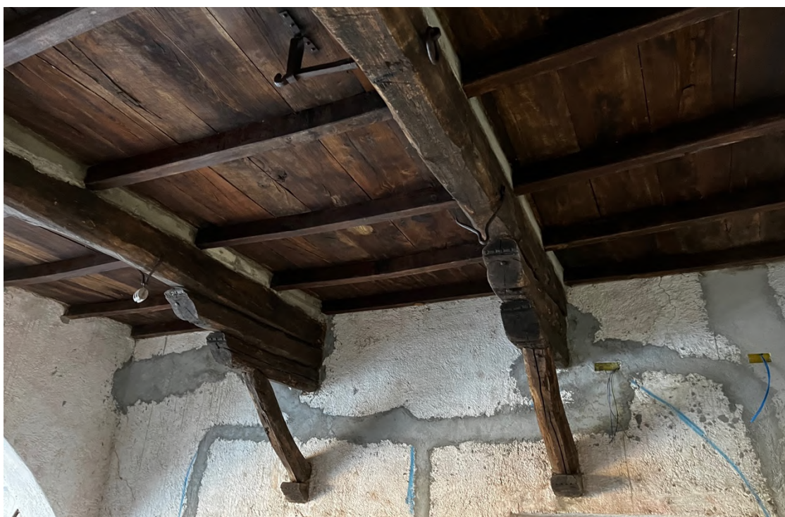
Fig. 53_ Immagine dell'intradosso del solaio a lavori ultimati. (Scatto in cantiere)
