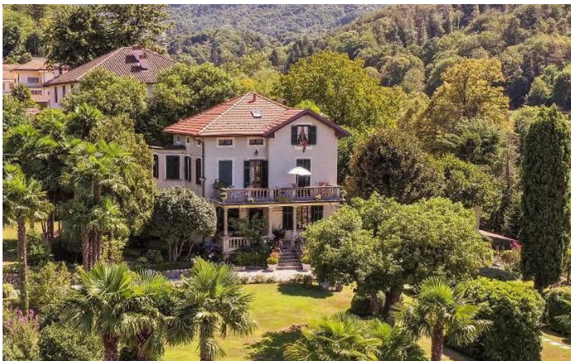
Fig. 21_ La villa allo stato attuale vista dal giardino. ( https://il-motto-di-tommy-castelveccana.hotelmix.it/ )
