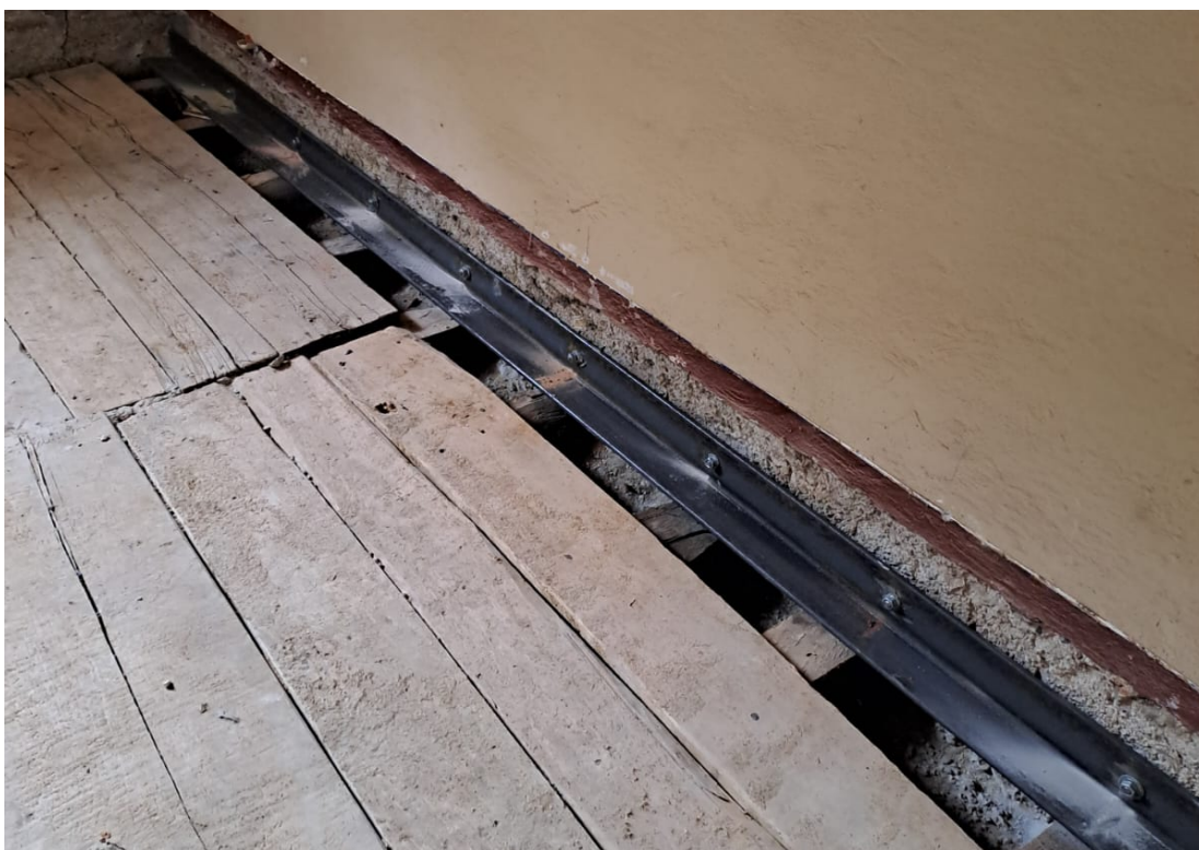
Fig. 49_ Immagine delle mensole fissate a muro che sostengono i nuovi travetti. (Scatto in cantiere)
