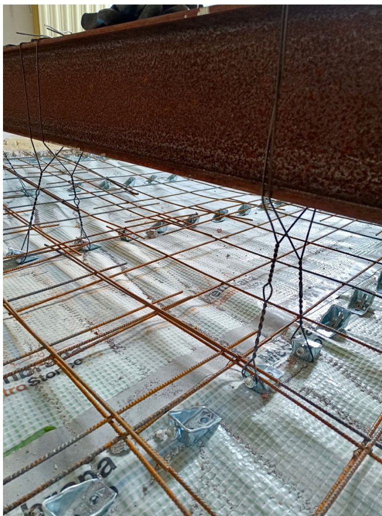
Fig. 41_ Posa delle legature tra connettori e trave per la sospensione del solaio. (Scatto in cantiere)
