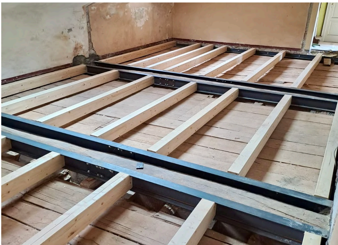
Fig. 48_ Immagine rappresentativa della nuova struttura in acciaio e legno. (Scatto in cantiere)
