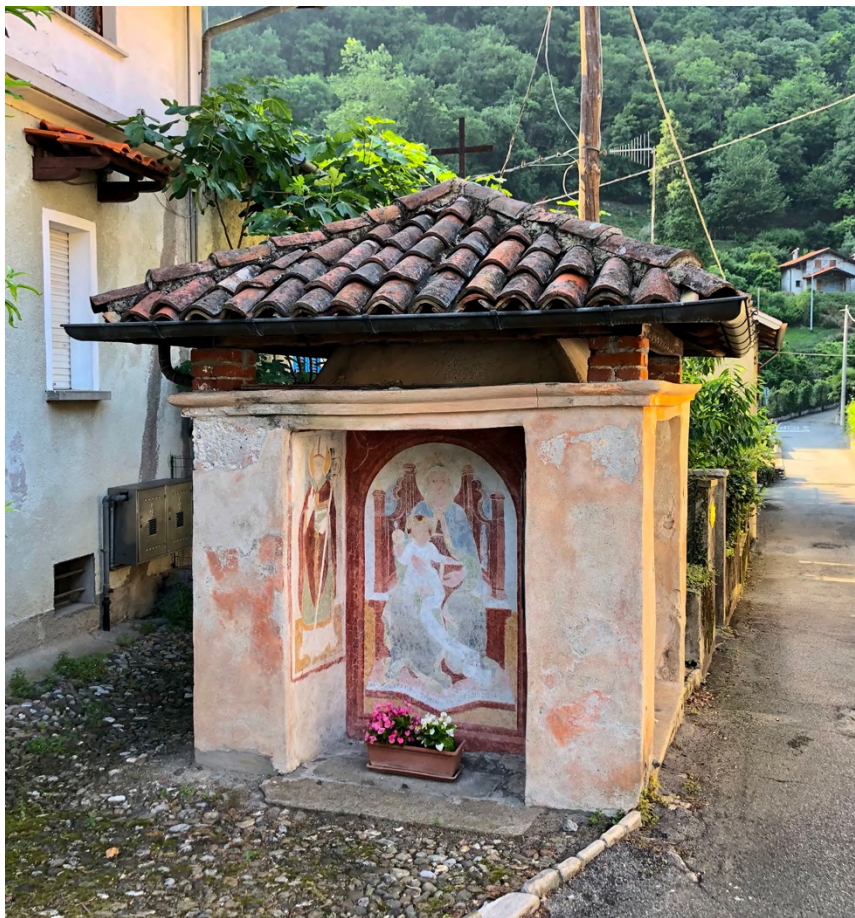
Fig. 16_ Fotografia della cappella del pozzo com'è oggi. (Elaborazione personale)
