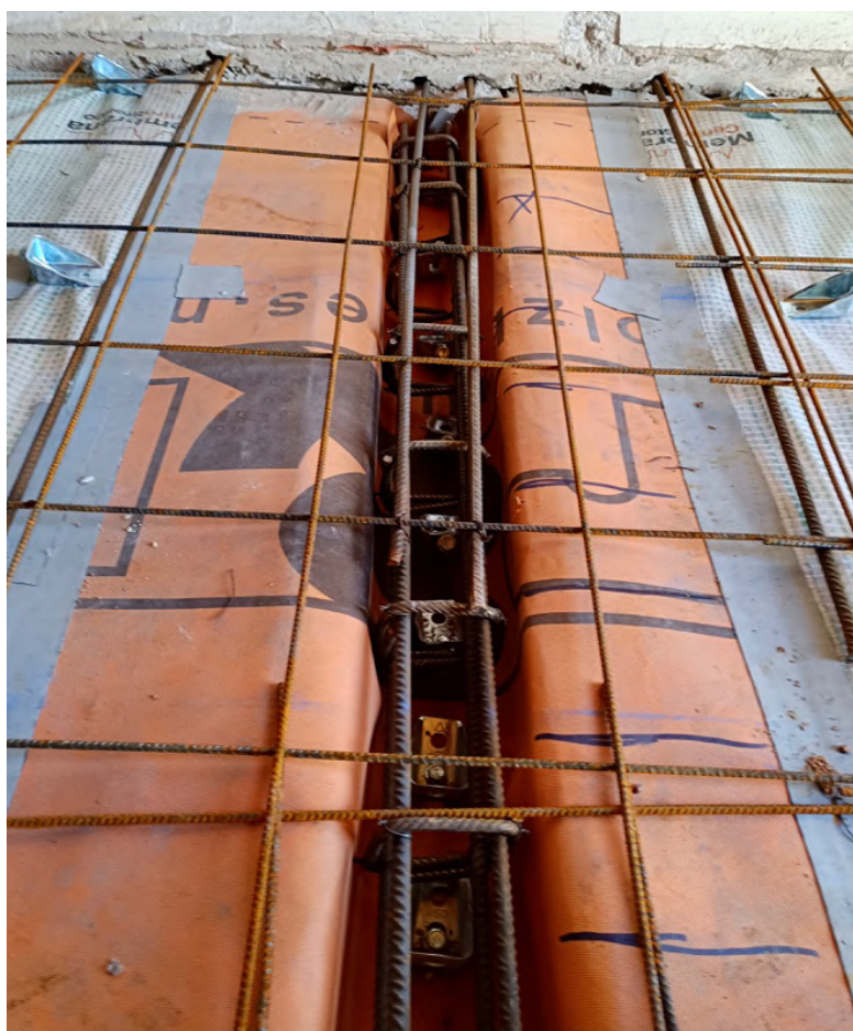
Fig. 43_ Immagine delle armature in corrispondenza delle travi principali. (Scatto in cantiere)
