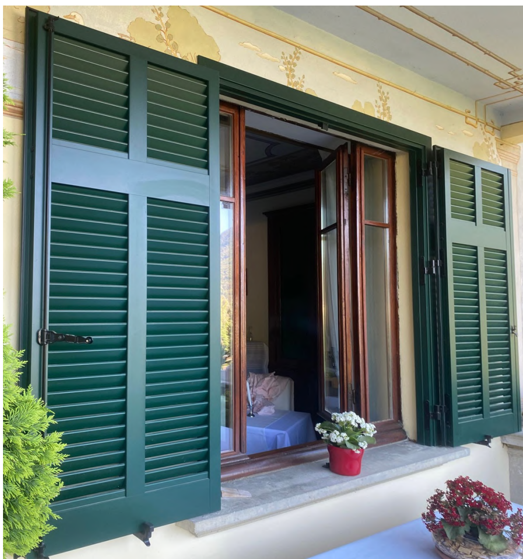
Fig. 30_ Finestra restaurata, che affaccia sulla loggia al piano rialzato. (Immagine scattata in loco)
