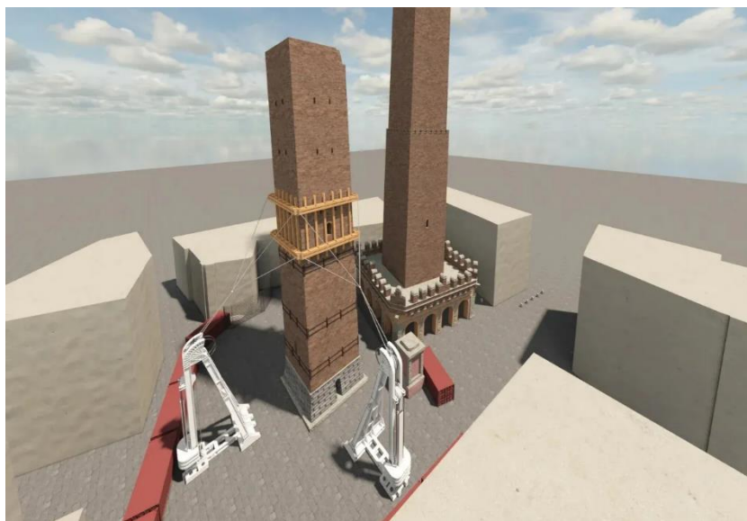
Figura 8: Il gemello digitale della Torre Garisenda con cerchiaggio e tralicci
