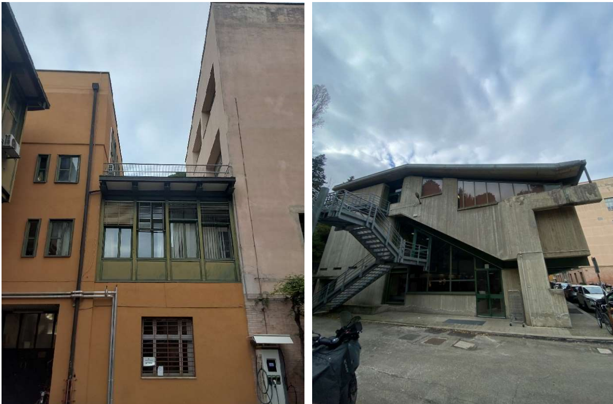
Figura 18 - Nuovo edificio che prolunga un pettine dell'edificio esistente (sx) e funge da collegamento per la nuova struttura in C.A-Acciaio. (dx)
