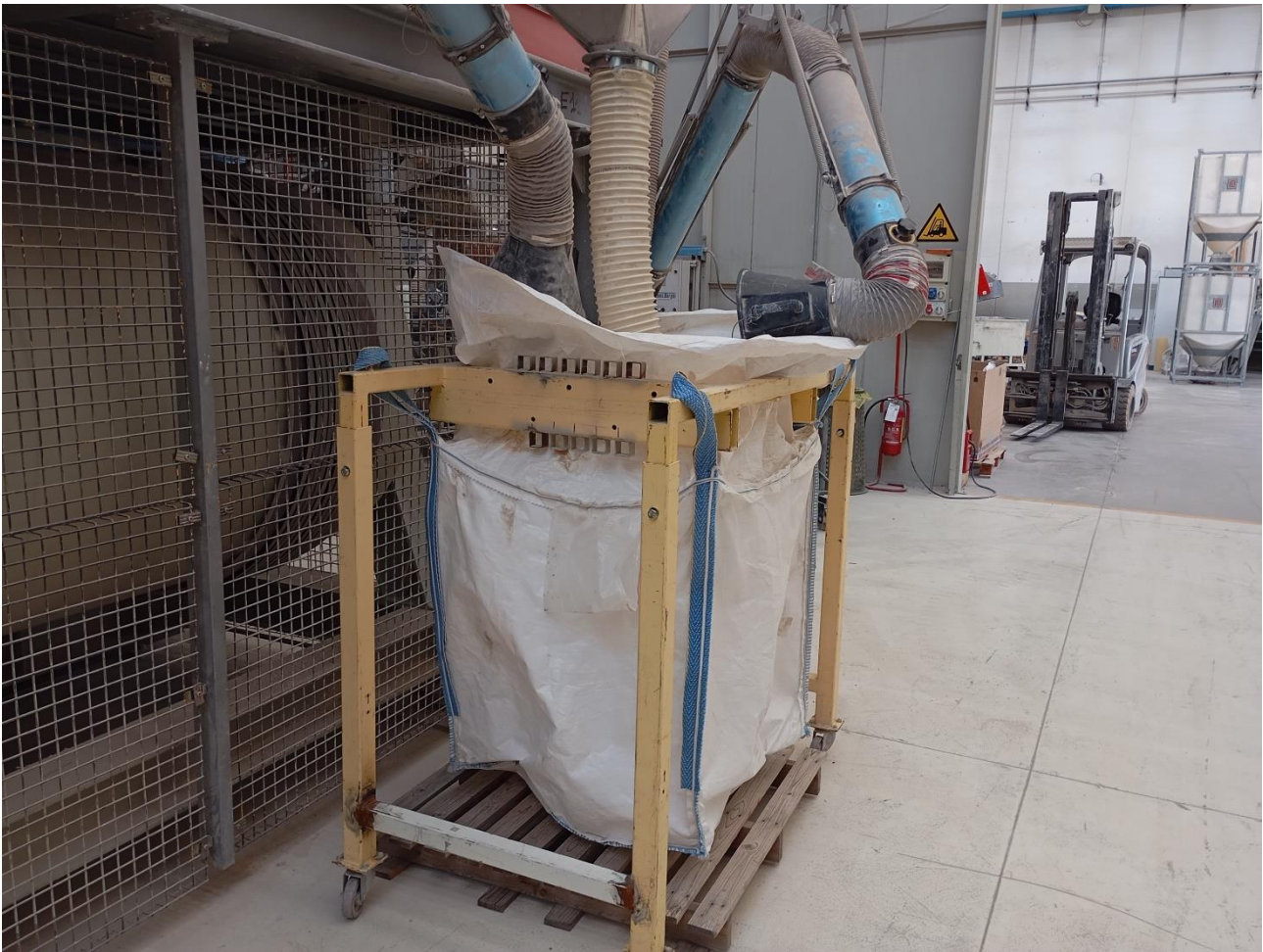
Figura 7 recipiente di raccolta del prodotto fine, impianto pilota laboratorio LB technology
