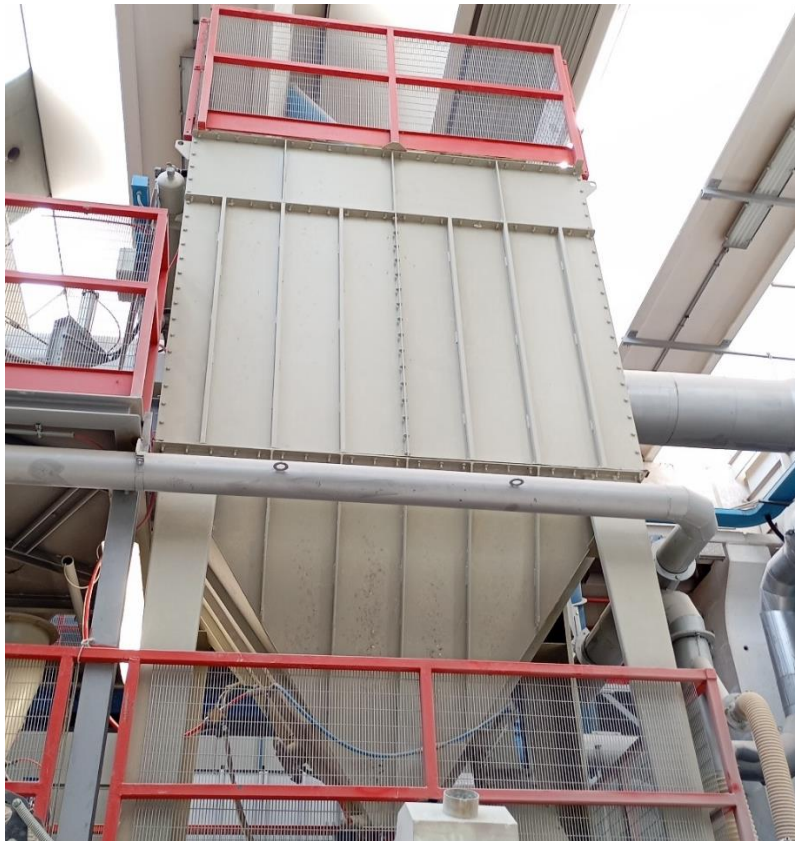
Figura 6 filtro a maniche impianto pilota, laboratorio LB technology
