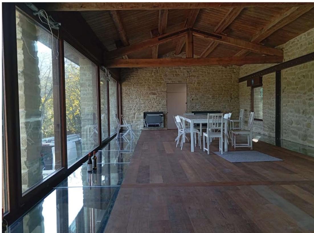
Fig. 23 Il solaio sospeso che verrà adibito a sala degustazioni
