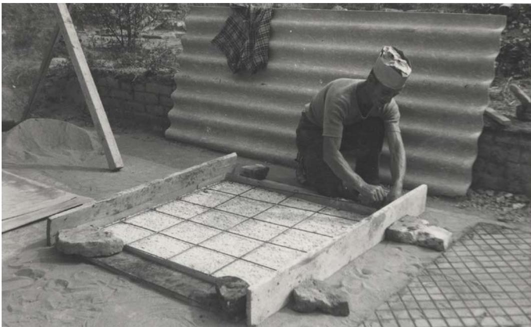
Fig. 30. Casseratura del supporto in calcestruzzo armato, s.d.
