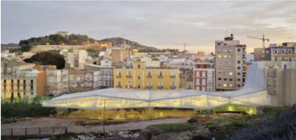
Fig. 11 - Copertura dell'Insula romana del Molinete (fonte: Industria delle Costruzioni n 429).
