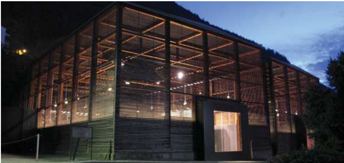
Fig. 13 - Copertura del sito archeologico di Coira di P. Zumthor (fonte: www.clemsoningenoa.com ).
