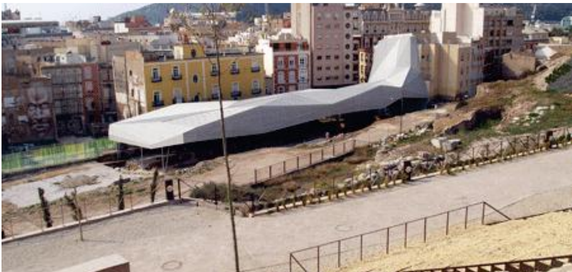
Fig. 28 - Copertura dell'Insula romana del Molinete (fonte: www.valencia.es ).
