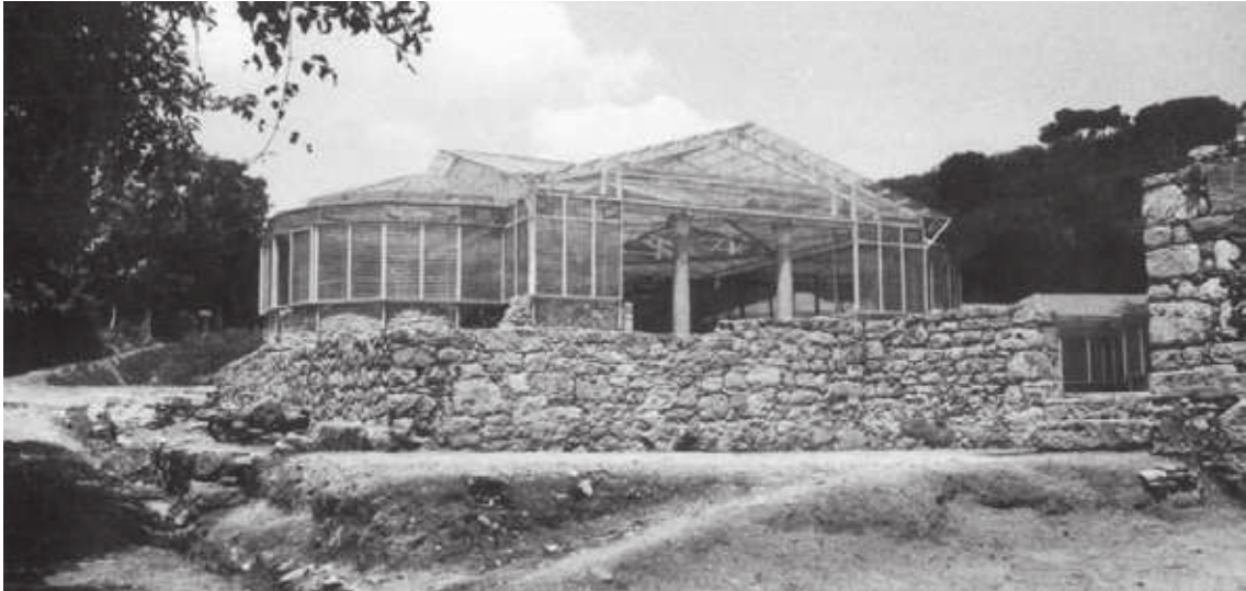
Fig. 12 - Copertura delle mura di Villa del Casale a Piazza Armerina (fonte: Coperture archeologiche - allestimenti protettivi sui siti archeologici).
