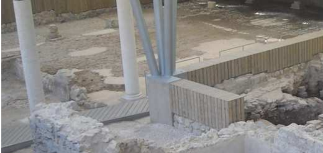
Fig. 22 - Attacco di uno dei pilastri in corrispondenza delle murature antiche dell'Insula del Molinete a Cartagena (S. Di Conza).
