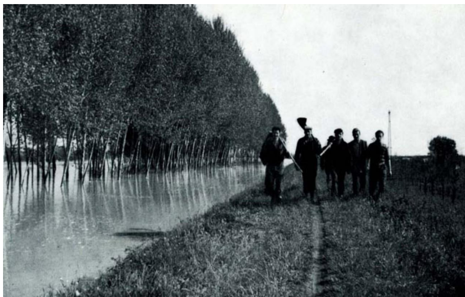
Rottura degli Argini del fiume Secchia, nel maggio 1960 (da Cavezzo attraverso le immagini)
