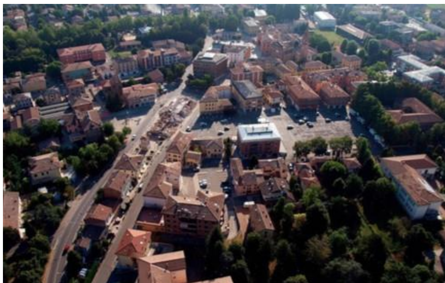
Foto area del centro di Cavezzo dopo il sisma (Foto di Nelson Cavezzo)
