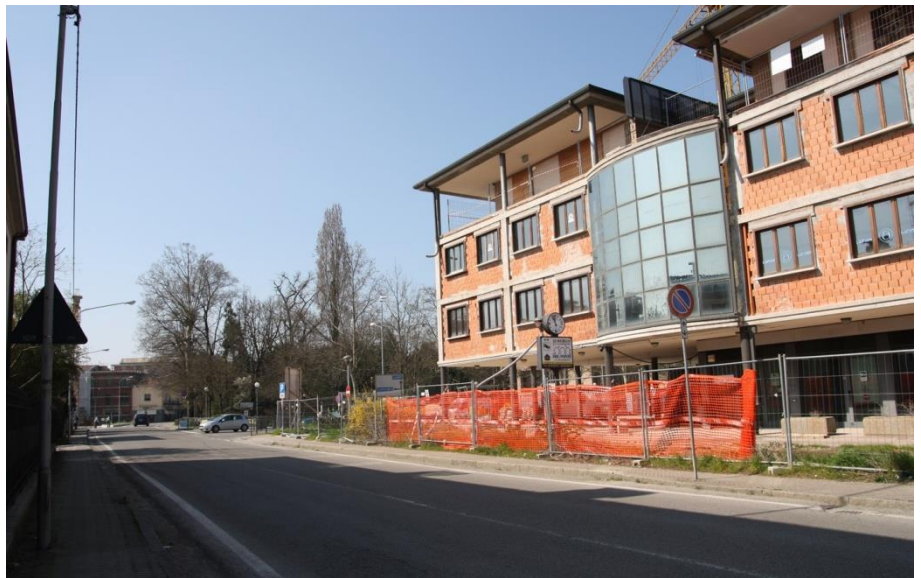
Foto del centro di Cavezzo dopo il sisma, 2014
