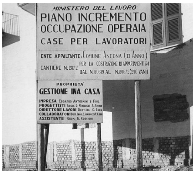
Cartello di cantiere
