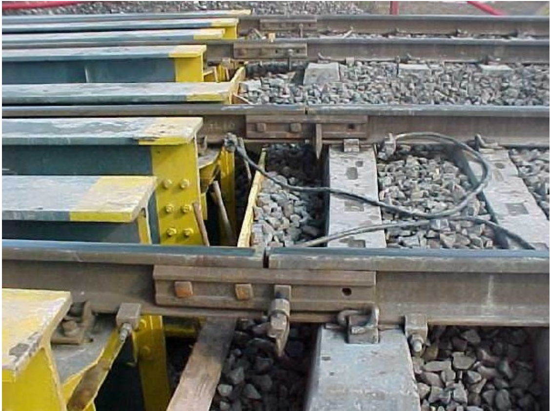
Fig. 3 – Travi gemelle che sostengono i binari
