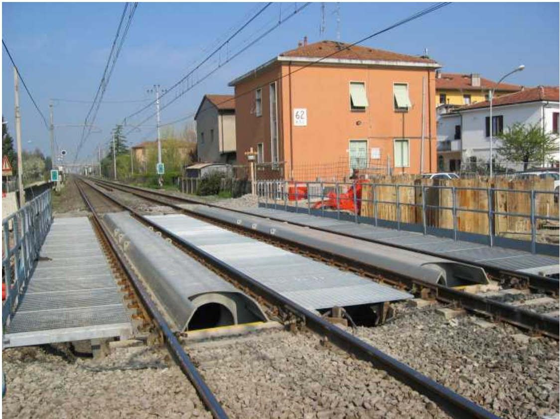
Fig. 8 – Ponte Bologna di tipo a luce ridotta in opera
