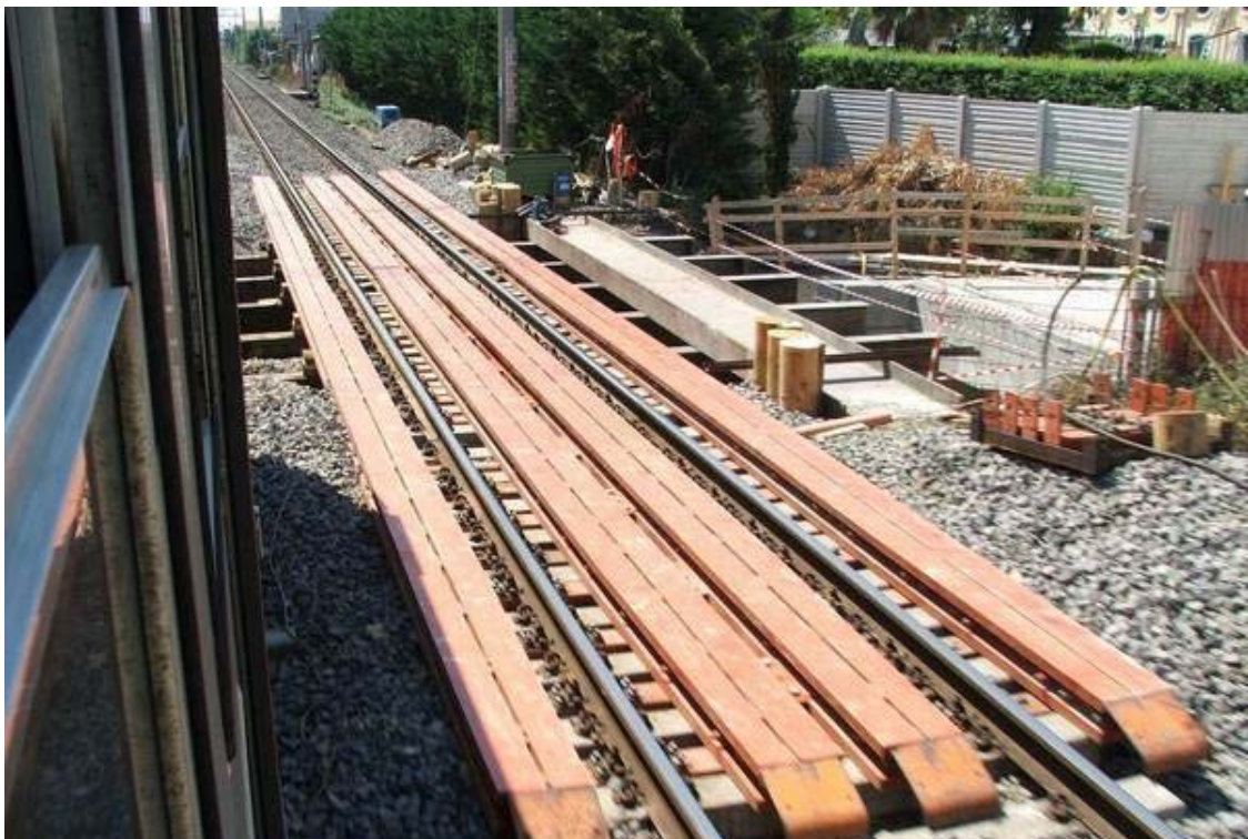
Fig. 9 – Ponte Essen: sono visibili i pali infissi nel terreno, la travi di manovra ortogonali al binario e una delle due travi di controvento (sulla destra)
