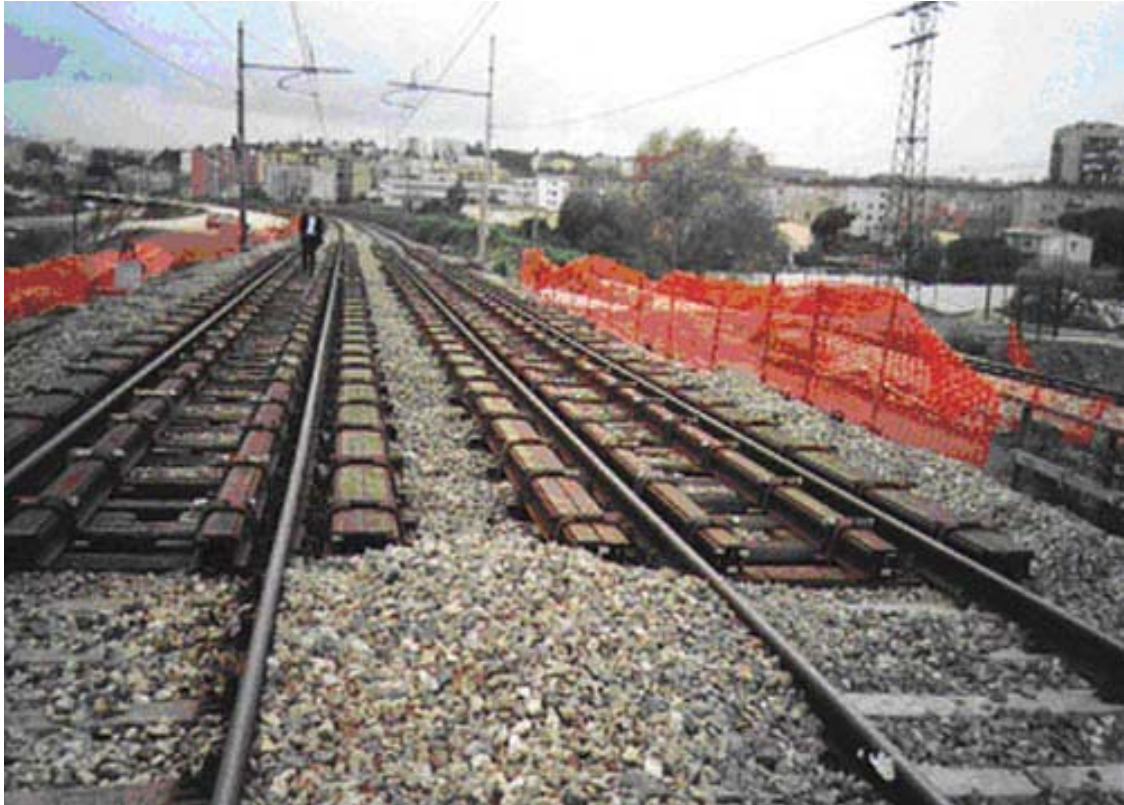
Fig. 2 – Fasci di rotaie
