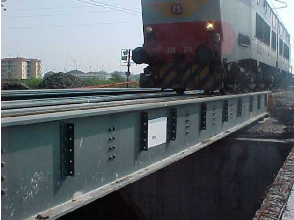
Fig. 4 – Travi gemelle che sostengono i binari con treno in transito presso Parma
