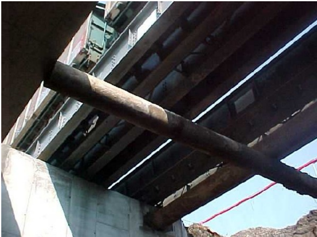
Fig. 5 – Vista dal basso di un ponte provvisorio realizzato con travi gemelle
