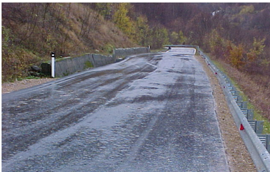
Figura 87 - Condizioni del tratto di tracciato di variante immediatamente a valle del tornante.
