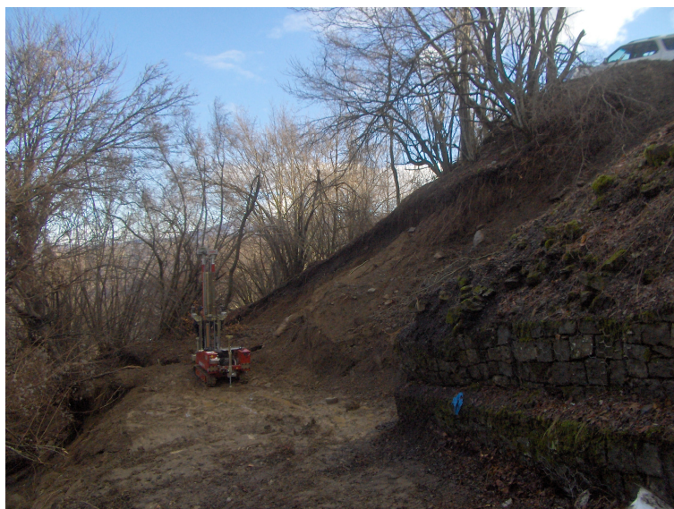
Figura 106 - Lavori di consolidamento del tornante di monte.
