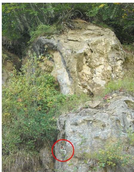
Figura 147 - Installazione di un prisma su parete rocciosa.
