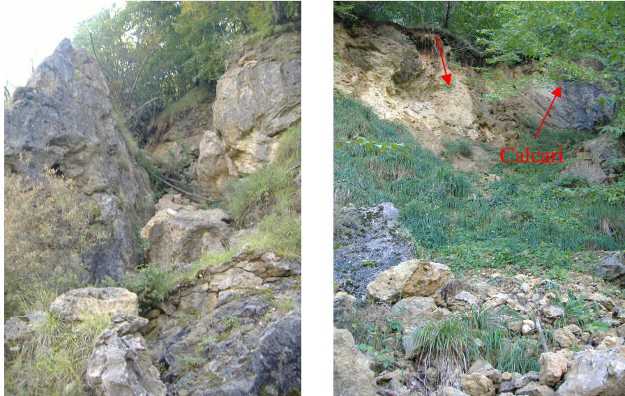
Figura 136 - Fronte inferiore, con in evidenza un trench, e nicchia di distacco superiore.
