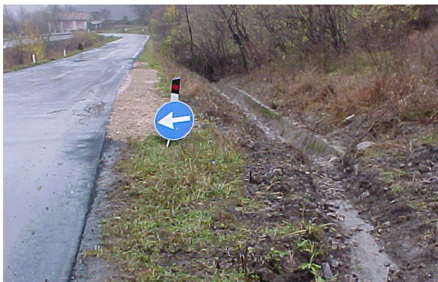
Figura 86 - Condizioni del tratto di tracciato di variante a monte del tornante.
