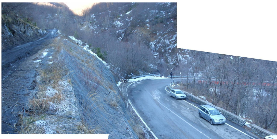
Figura 107 - Posa di reti di protezione in prossimità del tornante di valle.
