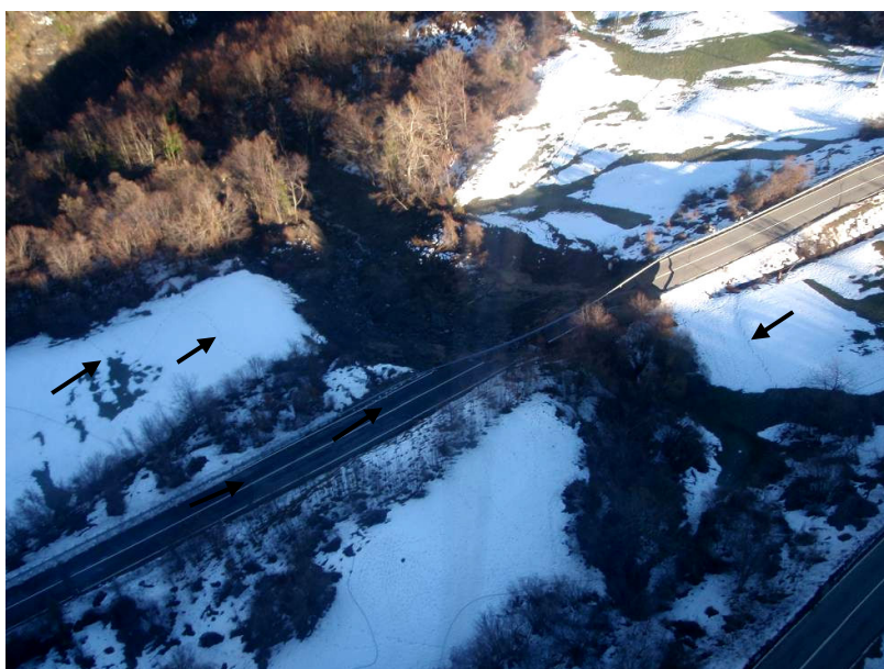
Figura 97 - Vista da tergo del dissesto principale.
