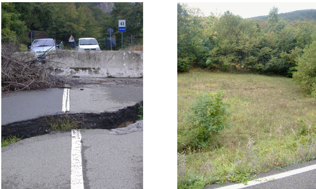
Figura 118 - Tension crack nel tracciato superiore, Evidenze di frana nel prato.
