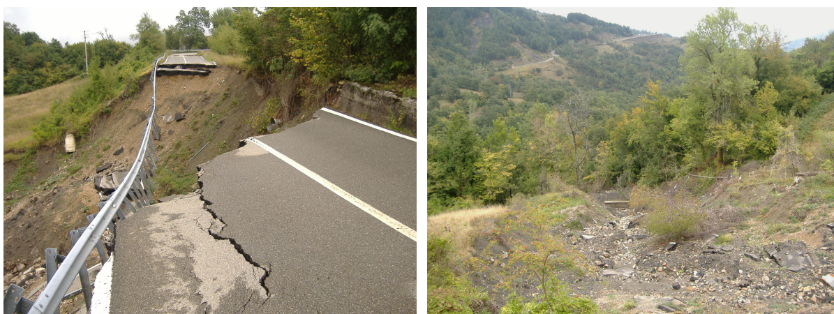
Figura 116 - Coronamento di frana, Corpo e piede di frana.
