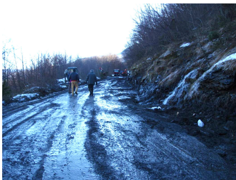
Figura 104 -Ruscellamento presente sulla sede stradale.
