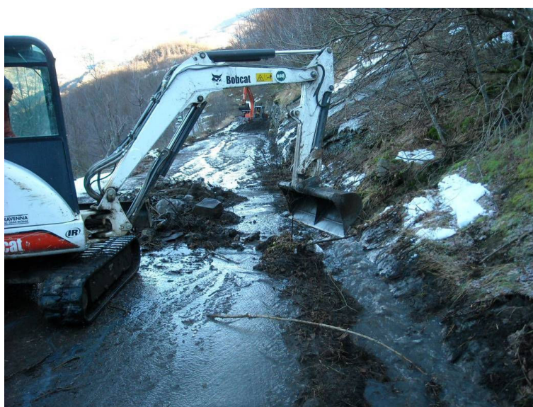
Figura 103 - Pulizia del manto stradale dai detriti presenti.
