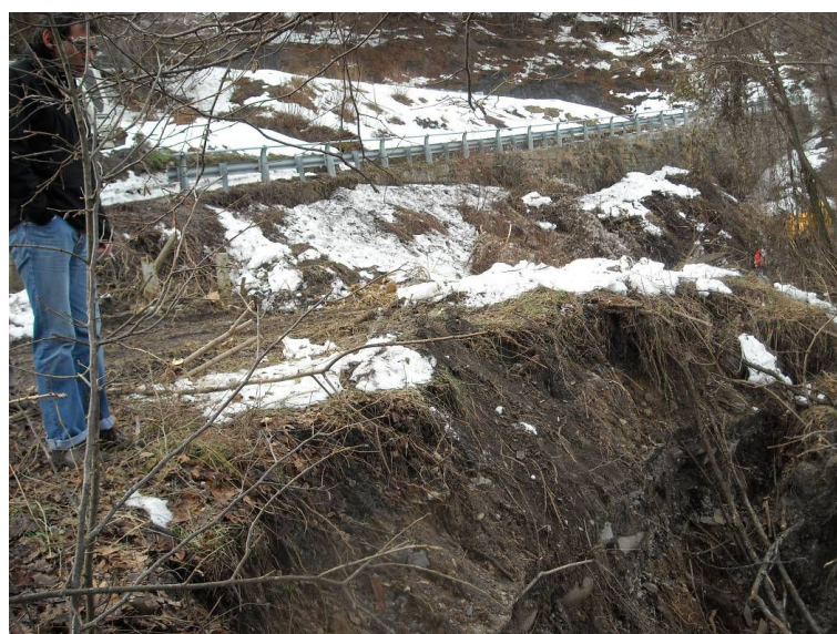
Figura 105 - Nicchia di distacco del movimento franoso in corrispondenza del tornante di monte.
