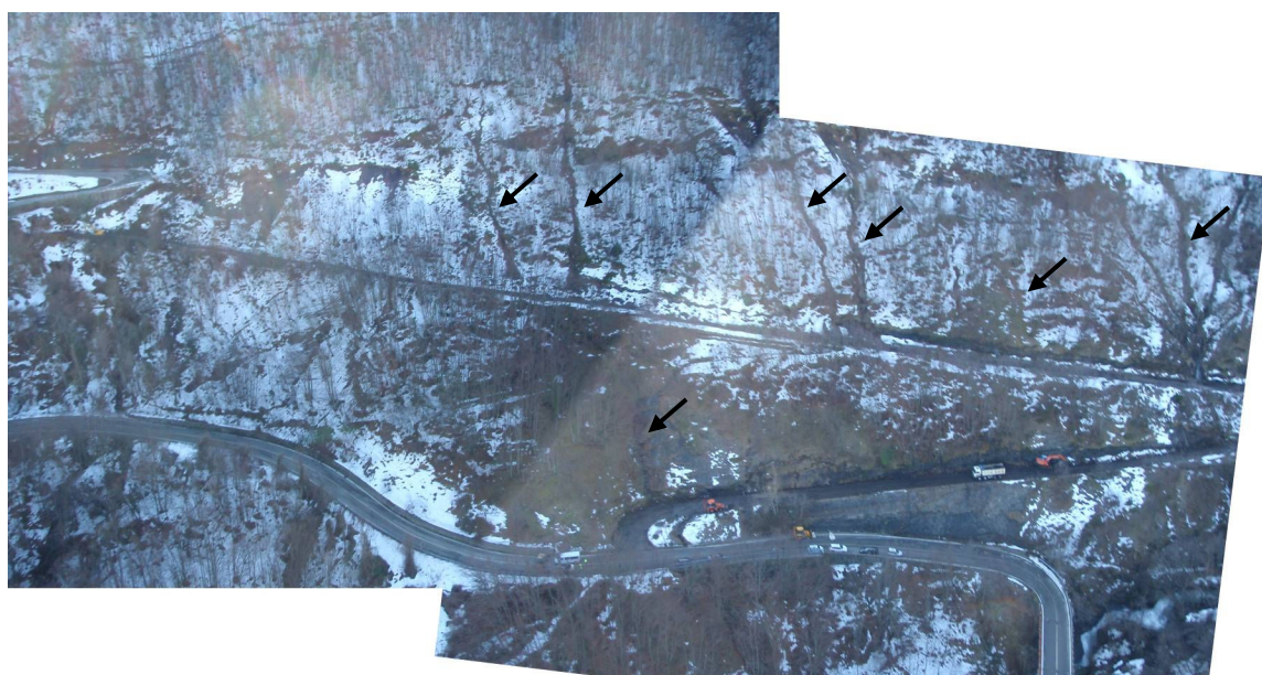
Figura 101 - Versante a monte del tracciato storico.
