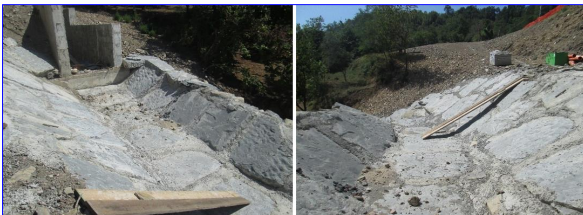
Figura 58: Veduta da S (sinistra) e veduta NE (destra) del canale di drenaggio a sezione trapezia.
