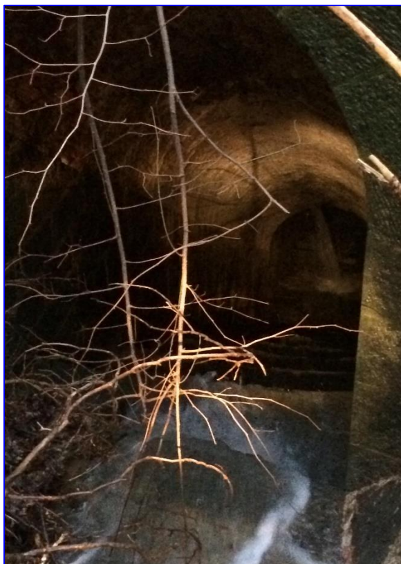
Figura 24: Tratto dell'opera idraulica creata per il defluire delle acque piovane e dell'impluvio a monte della ferrovia.
