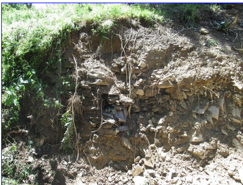
Figura 40: Detrito derivato dalla lavorazione antropica nei pressi del cantiere.
