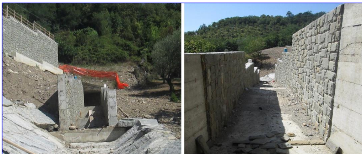
Figura 57: Veduta da SW (sinistra) e veduta da NE (destra) del canale di drenaggio a sezione rettangolare.
