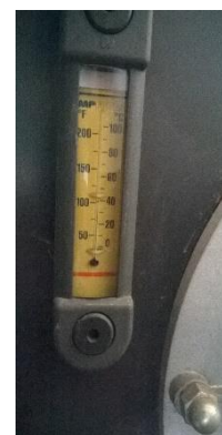
Figura 51 – Termometro per controllo della T dell'olio
