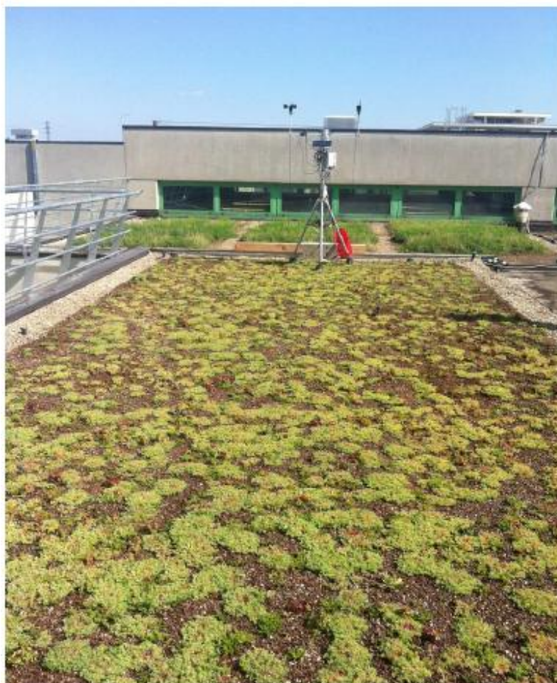
Fig.59 Green roof sui laboratori DICAM nel plesso di Ingegneria di via Terracini.
