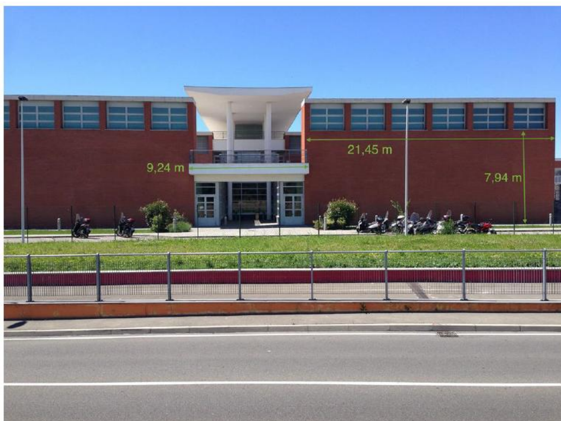
Fig.61 Facciata laterale dell'edificio esposta a Nord-Est (Aule TA02, TA04), stato attuale.
