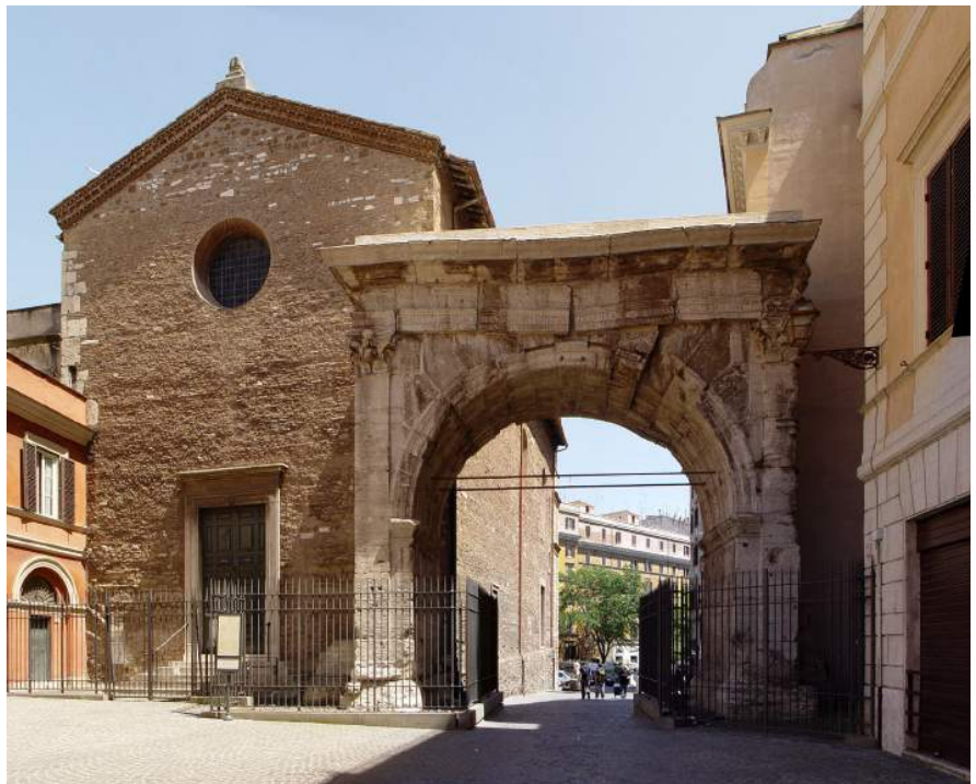
Arco di Costantino (detto Arco di Trionfo), Roma
