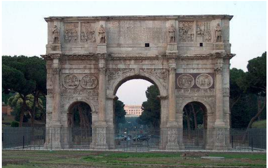
Arco di Costantino (detto Arco di Trionfo), Roma
