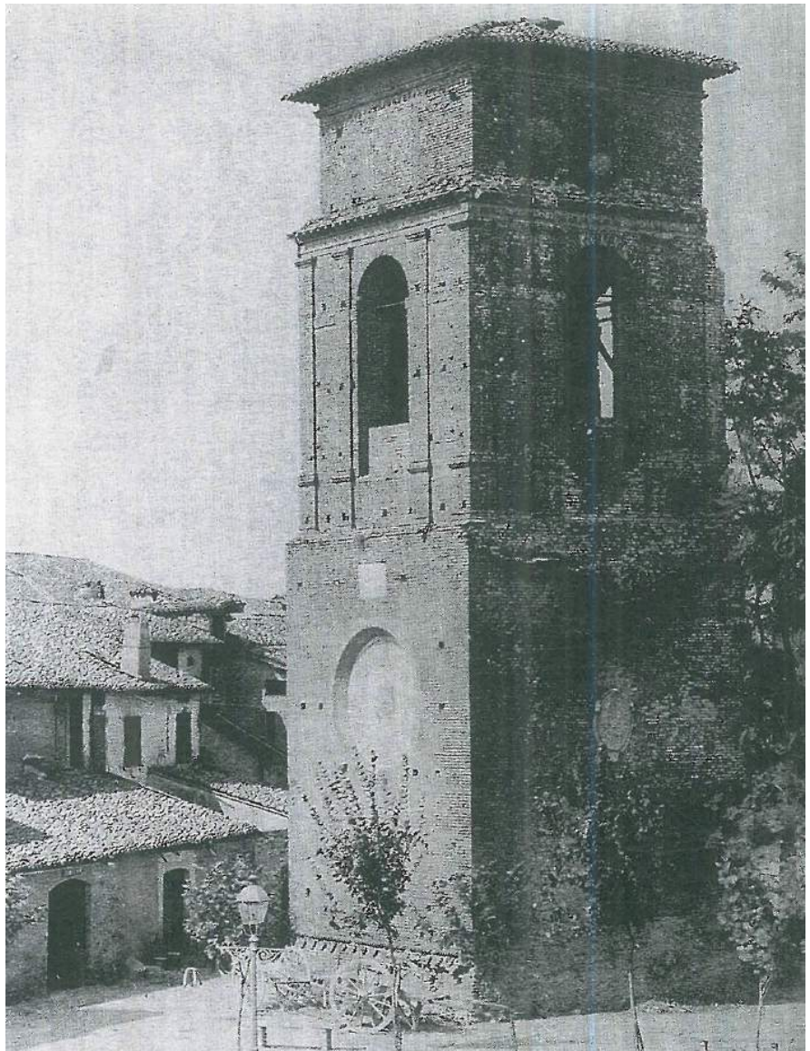
Torre di piazza della Costituente prima della demolizione.
