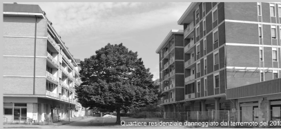
Quartiere residenziale danneggiato dal terremoto del 2012
