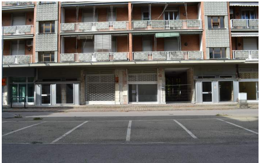
Danni causati dal terremoto
