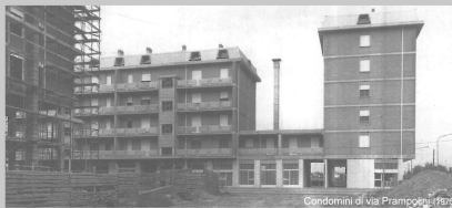
Condomini di via Pramoggini (1973)
