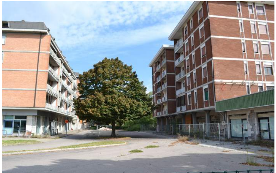
Palazzi danneggiati in modo irreparabile dal sisma del 2012
