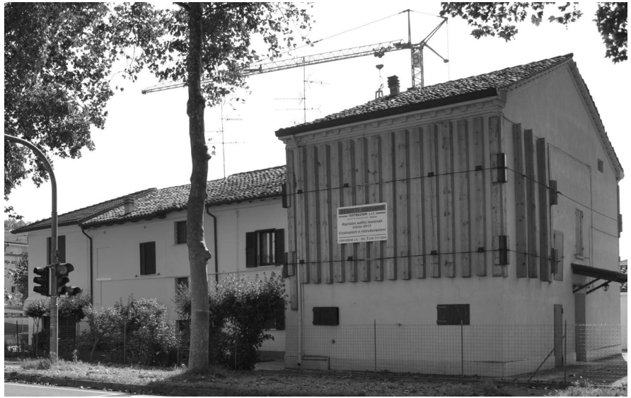
Sopra e a fianco alcuni danni del terremoto all'edilizia residenziale ed industriale della città.
