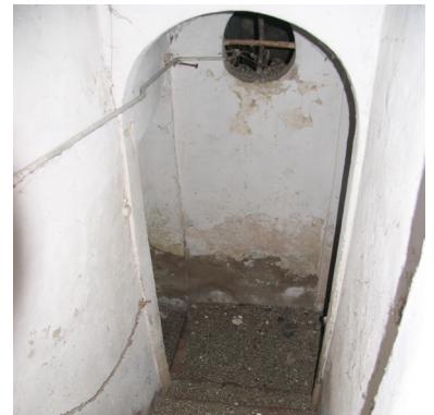
Fig. 3.64 Scala del fabbricato seicentesco.
