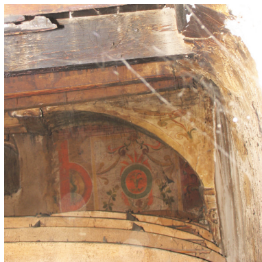
Fig. 3.12 Solaio tipo S 1.2. Struttura a mansola che in origine serviva a scaricare il peso di un camino monumentale soprastante.
