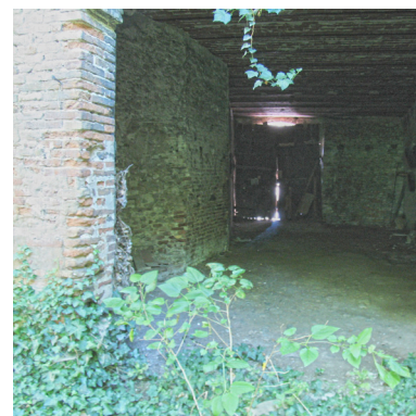
Fig. 34. Muro ad andamento spezzato nel passaggio coperto di via Foschini.
