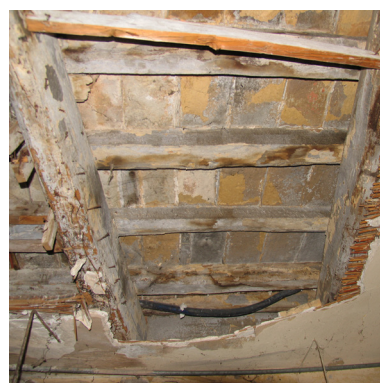
Fig. 3.30 Solaio tipo S 3
