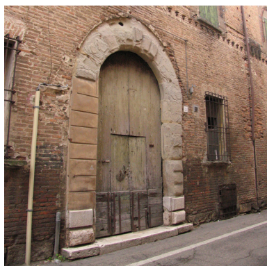
Fig. 3.89 Ingresso su via Comandini.
