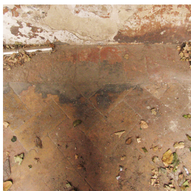
Fig. 3.68 Tipo P5. Pavimento del Portico.
