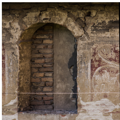
Fig. 3.107 Particolare della finestra a sesto ribassato con il disegno affrescato dello spartito architettonico.
