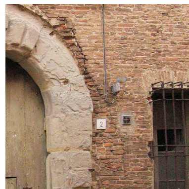
Fig. 18. Tracce nella muratura di un portale precedente.
