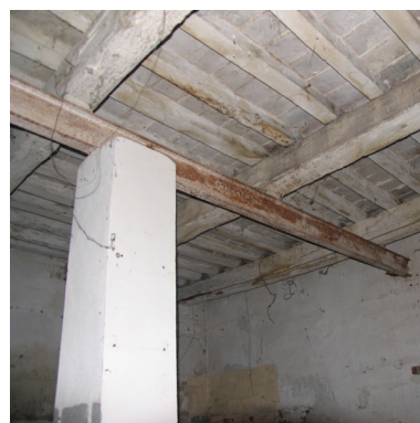
Fig. 3.31 Solaio tipo S 8
