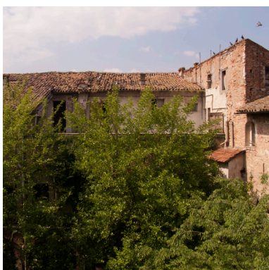
Fig. 3.52 Particolare della terrazza.
