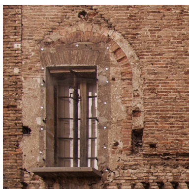
Fig. 21. Finestra rettangolare aperta nella posizione dell'antica finestra a tutto sesto.
