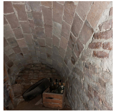
Fig. 3.63 Scala su via Manfredi. Particolare della volta in mattoni della prima rampa.
