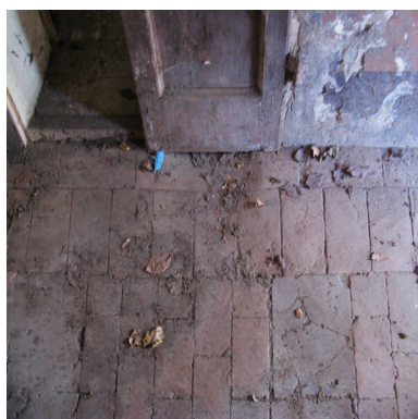
Fig. 3.67 Tipo P4. Pavimento dell'androne.
