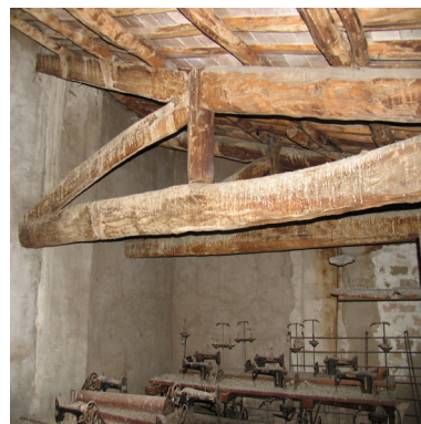
Fig. 3.57 Particolare della mezza capriata.
