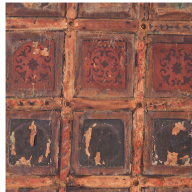
Fig. 3.22 Solaio tipo S 2 Particolare del decoro.
