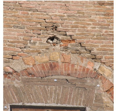
Fig. 3.102 Particolare della stratigrafia delle apertura a tutto sesto su via Comandini
