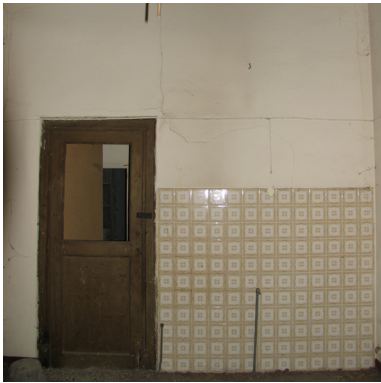
Fig. 3.127 Parete stanza VII. In questa posizione doveva esserci una cucina che ha causato la pellicola scura presente sulla superficie della volta.
