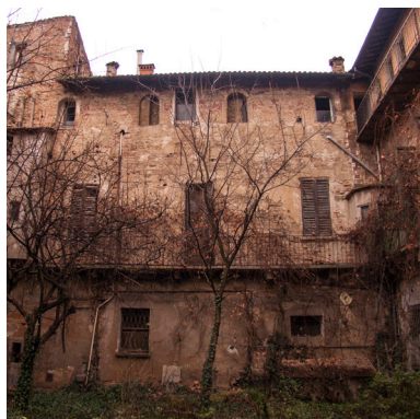
Fig. 3.105 Il prospetto occidentale della corte parallelo a via Manfredi.
