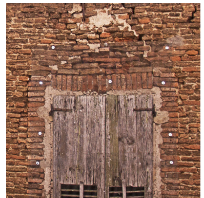
Fig. 09. Tracce nella muratura della precedente finestra a sesto acuto, appartenente alla casa torre.
