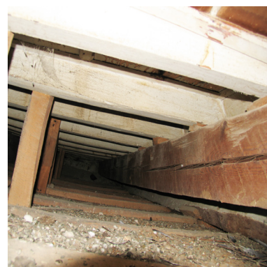
Fig. 3.82 Soffitto S3.2 Estradosso della falsa volta in arelle intonaca. Piano primo del palazzo cinquecentesco. Particolare della connessione tra la falsa volta e i travetti.
