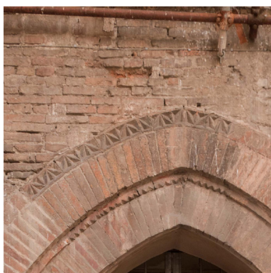
Fig. 3.98 Particolare delle ghiere decorative.
