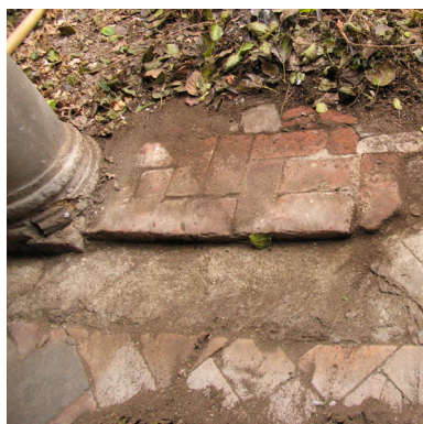
Fig. 3.69 Tipo P5. Pavimento del Portico.
