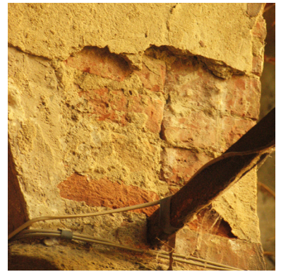
Fig. 3.47 Volta a crociera del portico. Apparecchiatura dei mattoni nell'imposta dell'arco.
