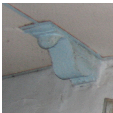
Fig. 3.20 Solaio tipo S 1.3. Particolare della mensola.
