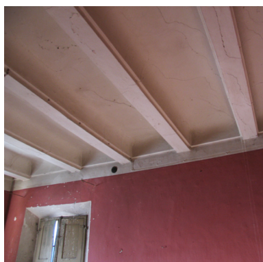
Fig. 3.84 Soffitto S5. Piano primo della casa torre.
