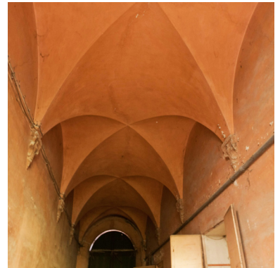
Fig. 3.49 Volte a crociera dell'androne.
