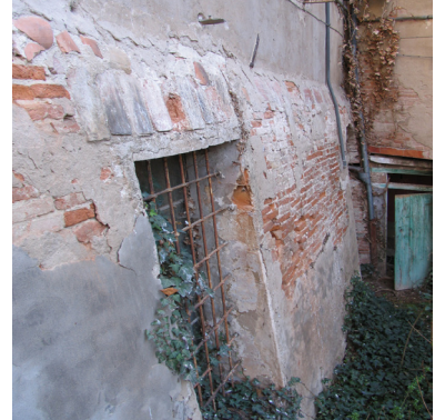
Fig. 49. Parete rastremata del fabbricato seicentesco sul lato settentrionale della corte.
