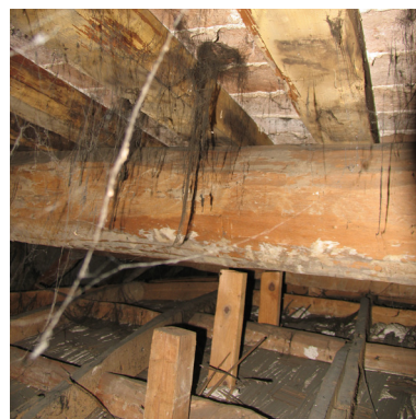
Fig. 3.109 Particolare dei montanti in legno che sorreggono il divisorio e forano la falsa volta.
