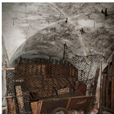
Fig. 3.43 Volta a crociera. Pilastro di sostegno in muratura.
