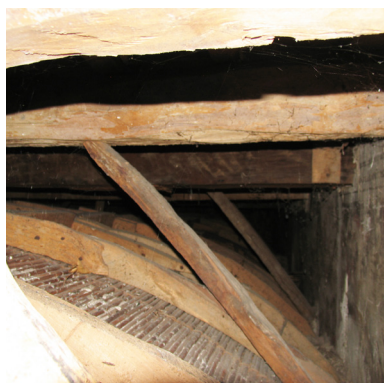
Fig. 3.78 Soffitto S3.1 Estradosso della falsa volta in arelle intonaca. Piano primo del palazzo quattrocentesco.
