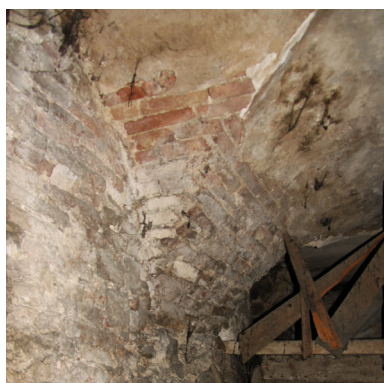
Fig. 3.44 Volta a crociera. Apparecchiatura dei mattoni nell'imposta.
