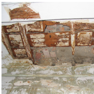
Fig. 3.17 Solaio tipo S 1
