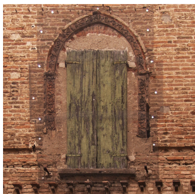
Fig. 20. Finestra rettangolare con scuri, aperta nella posizione dell'antica finestra a sesto acuto.
