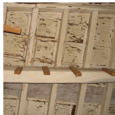
Fig. 17. Soffitto a cassettoni decorato al piano primo del palazzo quattrocentesco.
