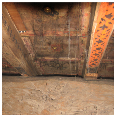
Fig. 13. Solaio a cassettoni decorato al piano terra del palazzo quattrocentesco.
