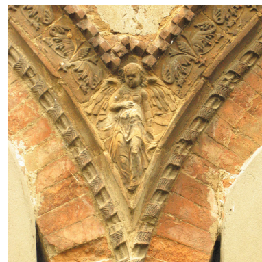
Fig. 25. Ghiera in terracotta dell'arcata del portico.
