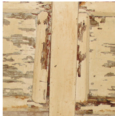
Fig. 3.14 Solaio tipo S 1.4. Particolare del decoro presente sul regolo.
