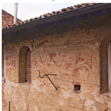
Fig. 30. Fascia affrescata al secondo piano della facciata corte dell'edificio cinquecentesco.
