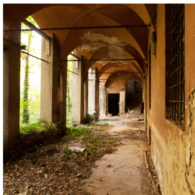
Fig. 3.46 Volte a crociera del portico.
