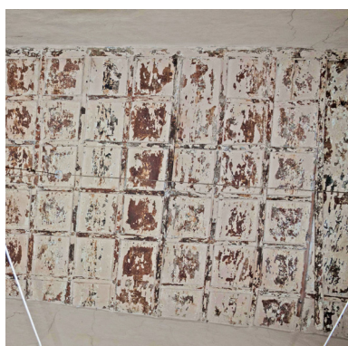
Fig. 37. Soffitto a cassettoni decorato, tagliato sul lato della nuova parete dell'atrio ottocentesco.
