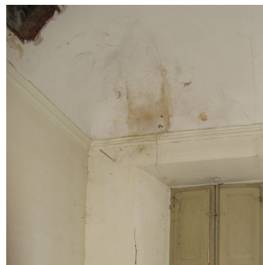
Fig. 3.112 In una delle due stanze più piccole è stata forata la volta. La lacuna è grave poiché si intravedono parti colorate, forse decorate.
