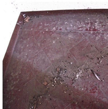
Fig. 3.73 Tipo P24. Pavimento delle sale nobili del palazzo.
