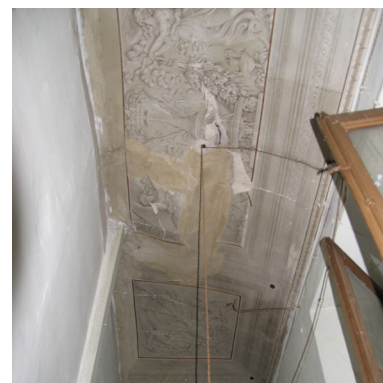
Fig. 3.119 La falsa volta ha subito un cedimento forse per via dell'umidità della stanza adibita a bagno.
