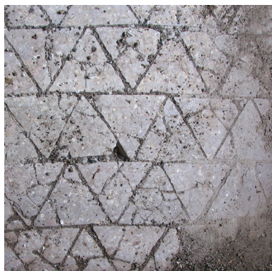
Fig. 3.70 Tipo P18. Pavimento del loggiato.
