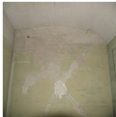
Fig. 3.111 Intradosso della grande volta. La partizione che divide l'ambiente.
