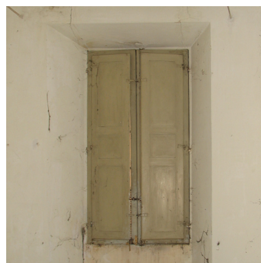
Fig. 3.86 Piano primo di via Comandini. Interno, con scuretti chiusi.
