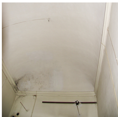
Fig. 3.77 Soffitto S3.1 Falsa volta in arelle intonaca. Piano primo del palazzo quattrocentesco.
