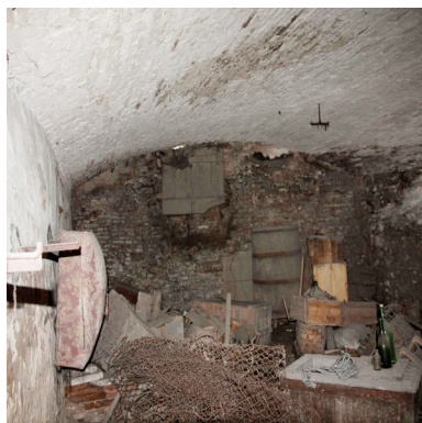
Fig. 3.45 Volta a botte.
