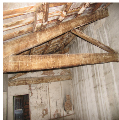
Fig. 3.58 Particolare della mezza capriata.
