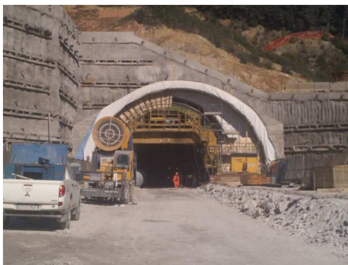
Fig.4.7-Imbocco nord Pk 5+510 galleria “Casal di Pari”. Foto del 12/11/2014.
