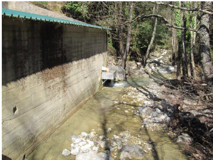
Fig. 11.8- Serbatoio di gestione acque sorgente “Le Caldanelle di Petriolo” con stramazzo di troppo pieno. Foto del 06/11/201.
