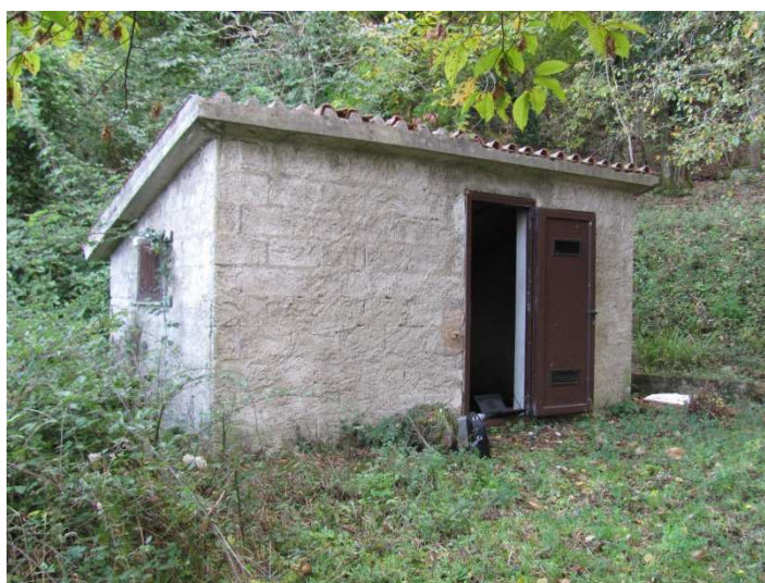
Fig.11.5-Bottino di presa sorgente “Porcareccia”, foto del 06/11/2014.
