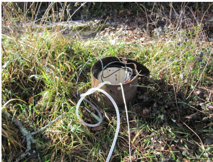
Fig.11.16-Piezometro C/P2. Foto del 06/11/2014.
