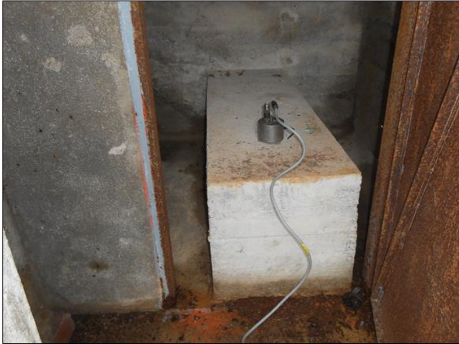
Figura 30 Acquisizione di microtremore all'interno di quella che è stata ipotizzata essere la vecchia sede per il sito TLM1, oggi dismessa.
