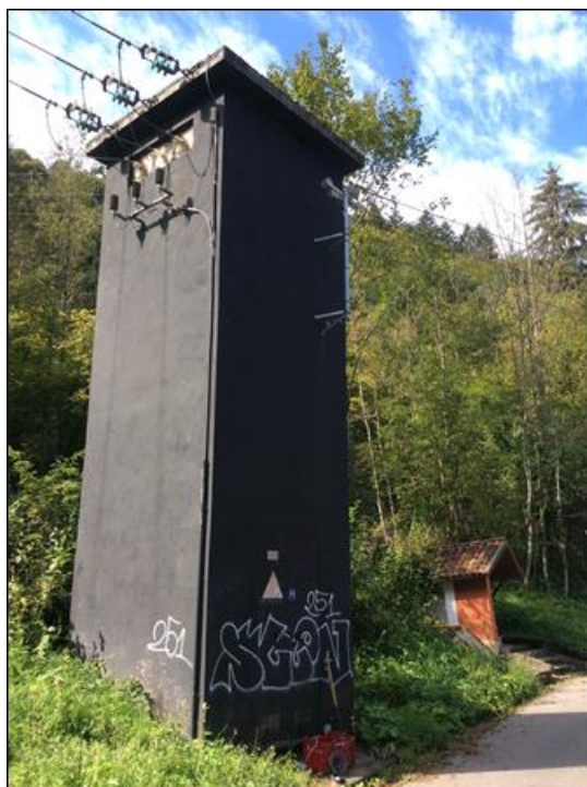
Figura 19 Stazione BRC ospitata nella cabina ENEL denominata “Vallata”, in comune di Barcis.
