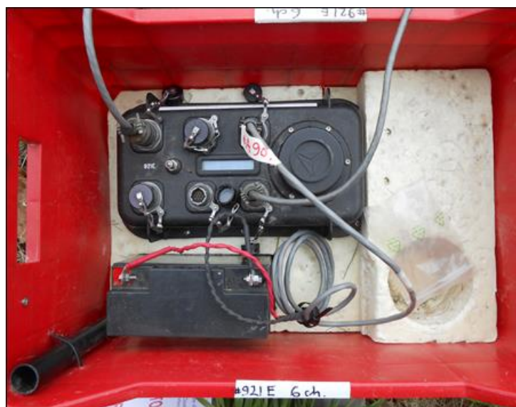
Figura 23 Acquisitore e batteria di alimentazione.
