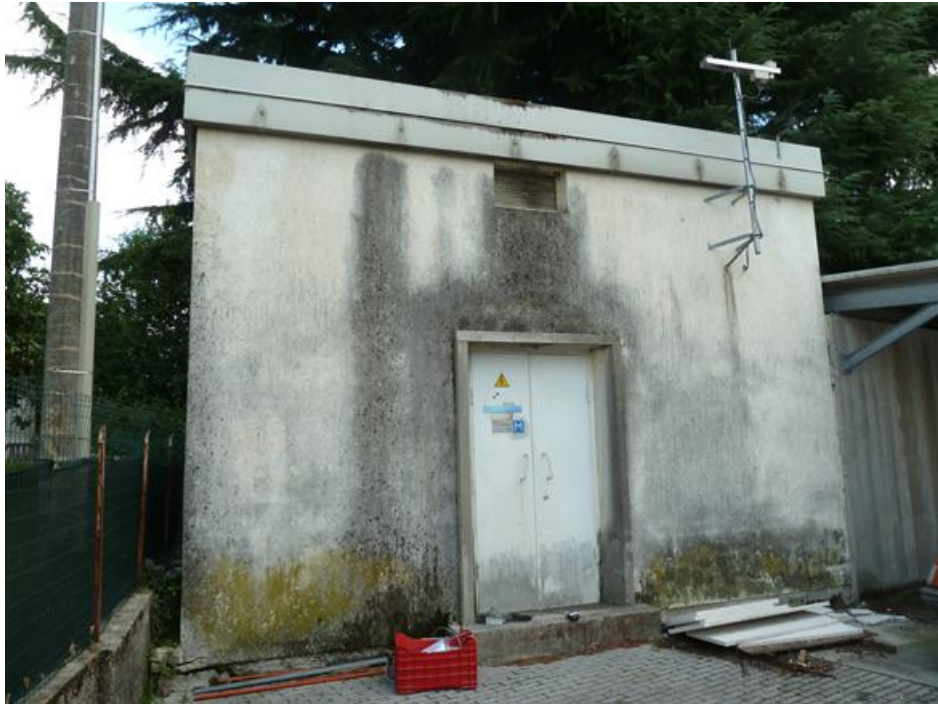
Figura 10 Sede della stazione MAI a Majano, dietro la sede municipale, ospitata dalla cabina ENEL denominata "Municipio".
