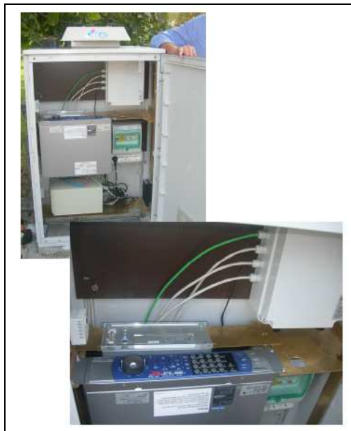
Fig. 5.6 – Centralina di comando
