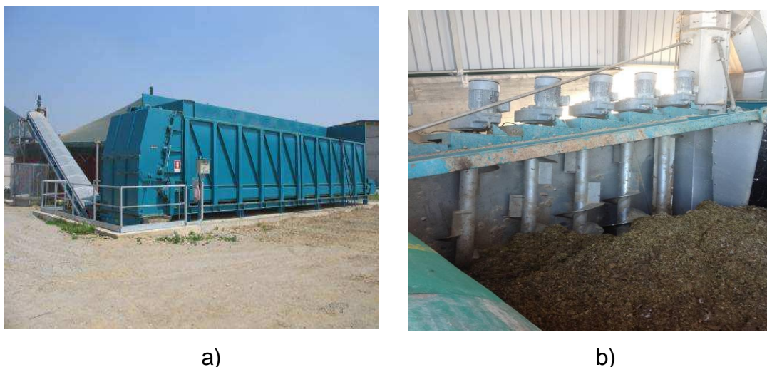
Figura 3.5 a) Tramoggia di carico con nastro trasportatore, b) coclea.
