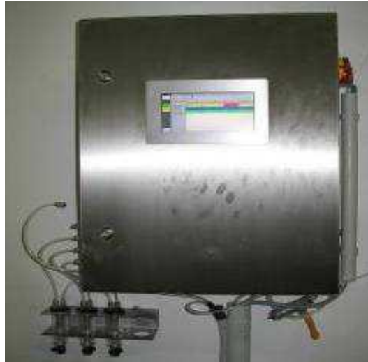
Figura 3.10 Misuratore qualità del biogas.
