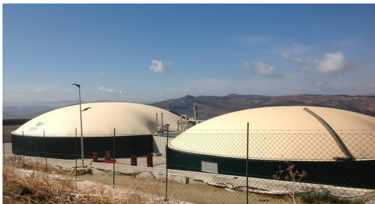
Figura 3.1 Digestori dell'impianto di Mussomeli
