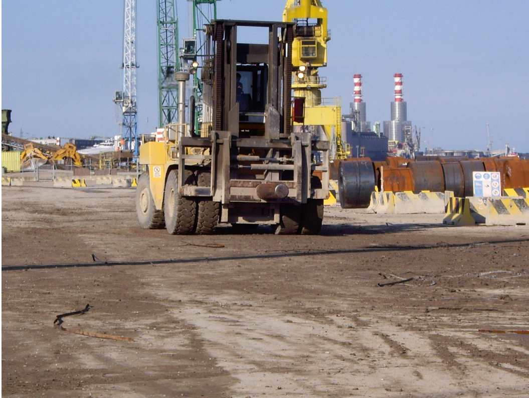
Fig. 3.3.4 – Hyster in esercizio in cantiere (vista frontale)
