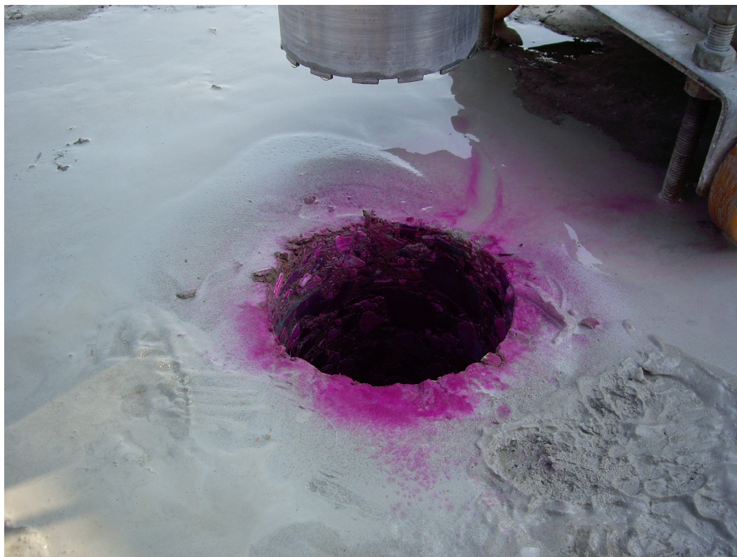
Fig. 3.2.8 – Foro di sondaggio.
