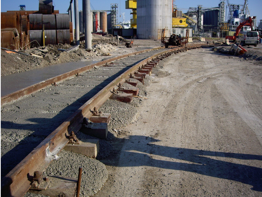
Fig. 3.1.4 – Ferrovia del piazzale dello stabilimento
