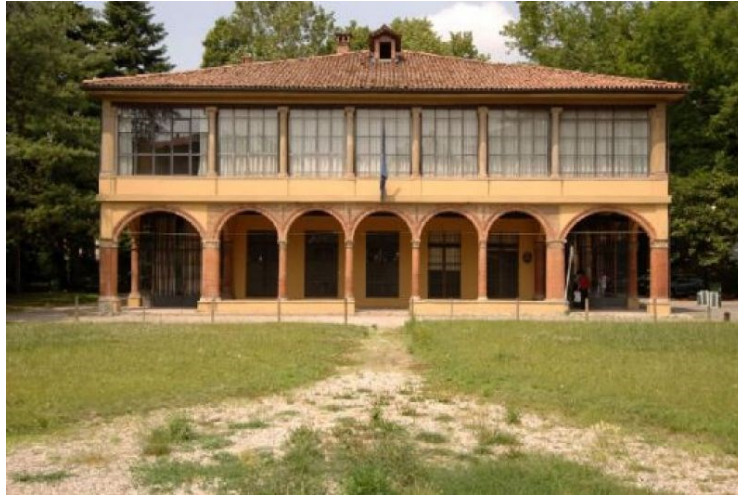
Figure 7.19: the East front side of Palazzina Della Viola.
