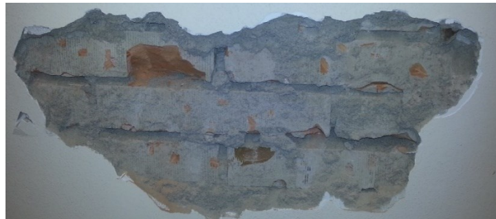
Figure 7.20: Masonry units and mortar of Palazzina Della Viola.
