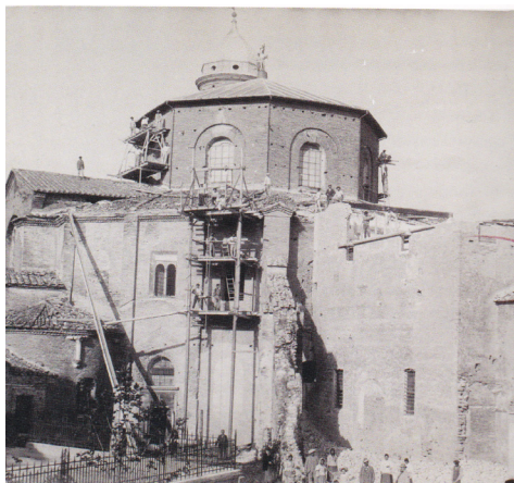
Demolizione cappella Sancta Sanctorum Basilica San Vitale 1901
