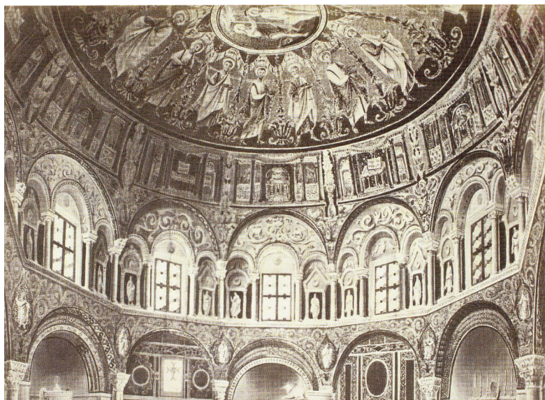
Fotografia Luigi Ricci 1869 prima degli interventi che restituirono le finestre alla forma originale
