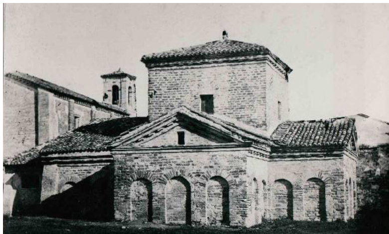
Foto Luigi Ricci esterno situazione addossamenti prima delle liberazioni
