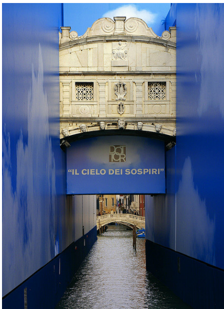
Impalcature per il restauro del Ponte dei Sospiri Venezia 2006
